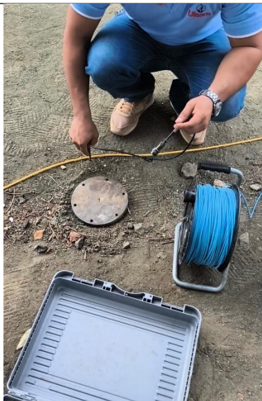
Fotografía 6. Instalación de los componentes en campo
