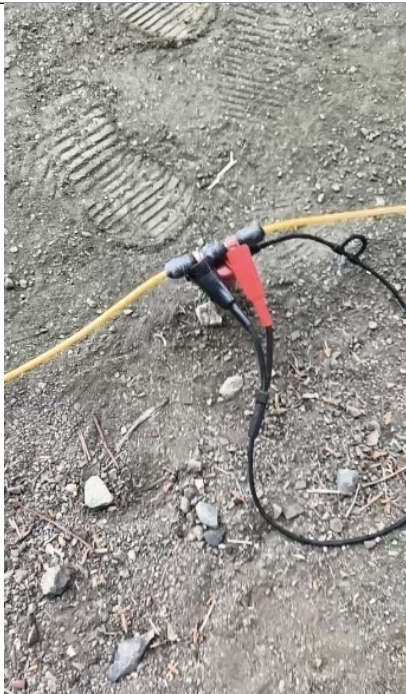
Fotografía 3. Conexión de los sensores
