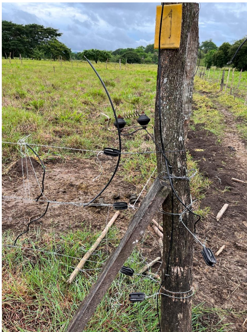
Nota. Cerca eléctrica en mal estado
