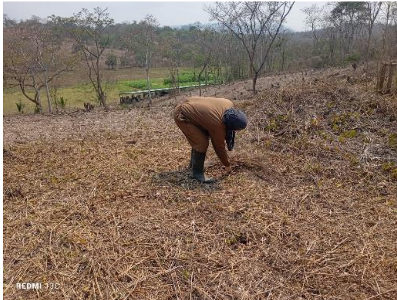
Figura 1: Limpieza del terreno
