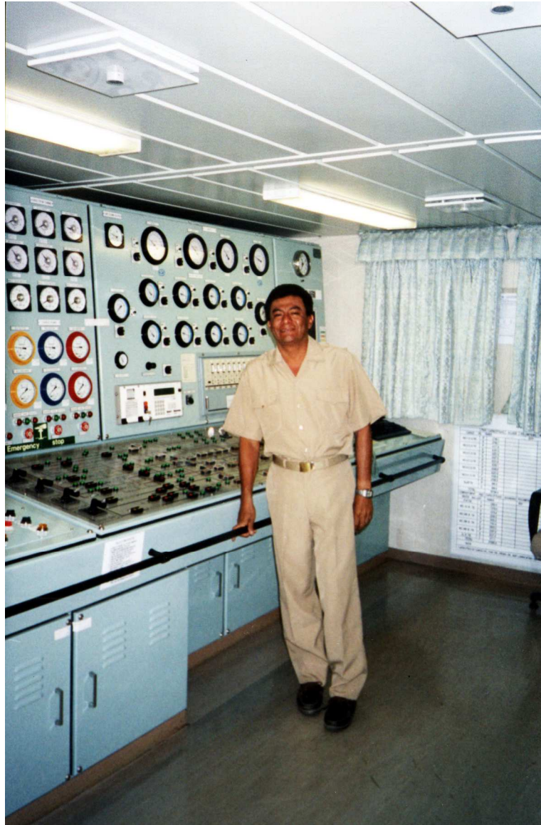
SUPERVISION DE CONSOLAS DE MAQUINAS
