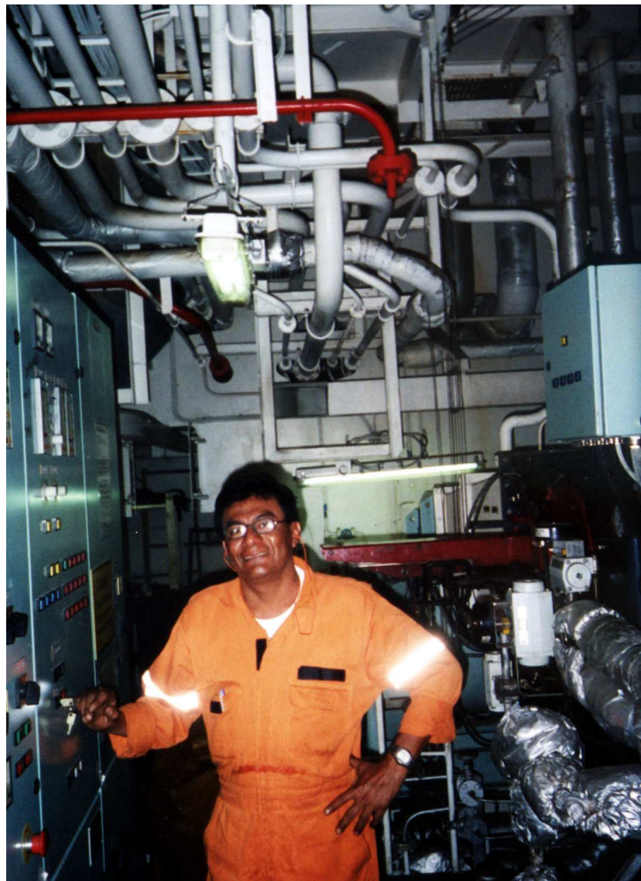
OPERANDO TABLERO DE CONTROL SIN PROTECCION DE CASCO
