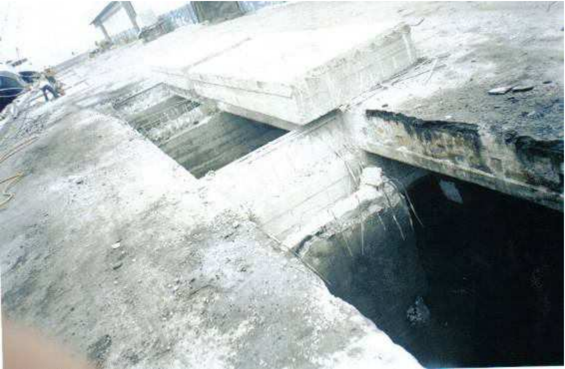
REPARACIÓN DE LOSA DEL MUELLE (SISTEMA PREFABRICADO)
