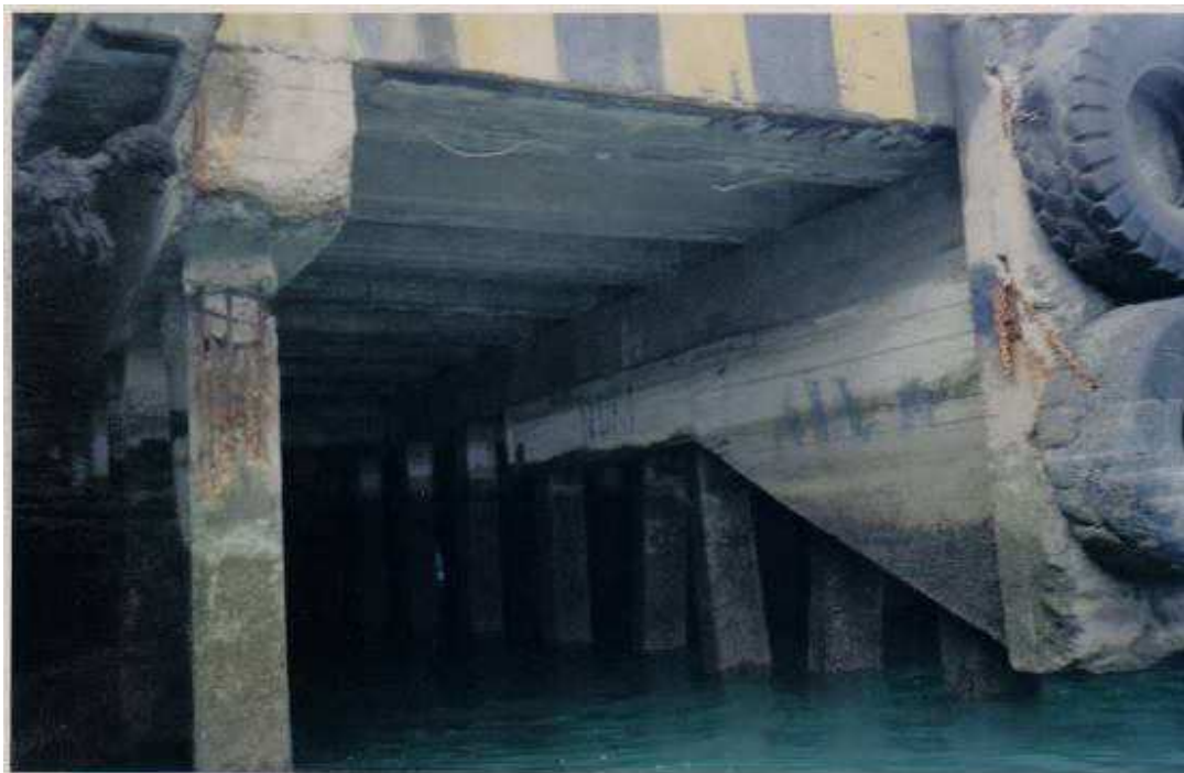
DAÑO Y TRATAMIENTO DE PILOTE
