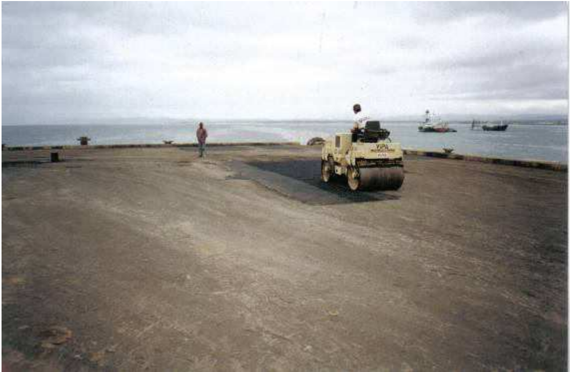
RECONFORMACION DEL PISO DEL MUELLE CON MATERIAL ASFÁLTICO
