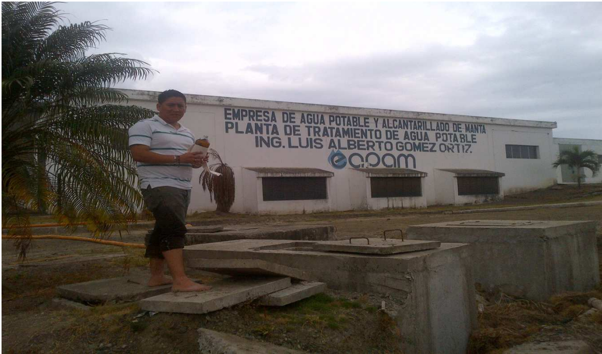
ANEXO 14. PLANTA DE TRATAMIENTO DE AGUA POTABLE ING. LUIS ALBERTO GOMEZ ORTIZ
