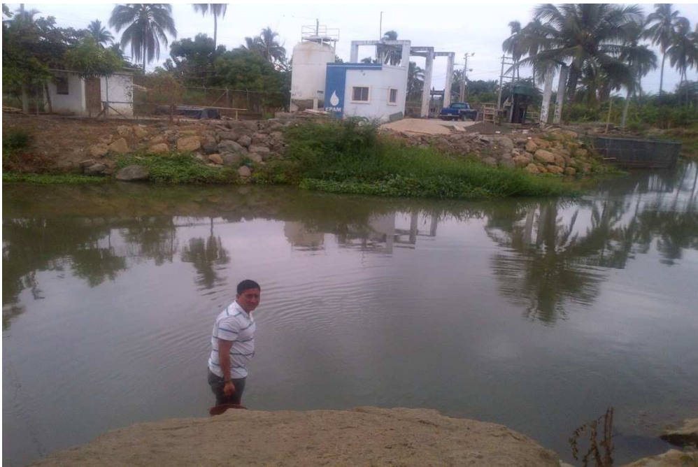
ANEXO 13. TOMA DE AGUA CRUDA EL CEIBAL
