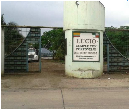
LAGUNAS DE TRATAMIENTO DE AARR DE PORTOVIEJO
