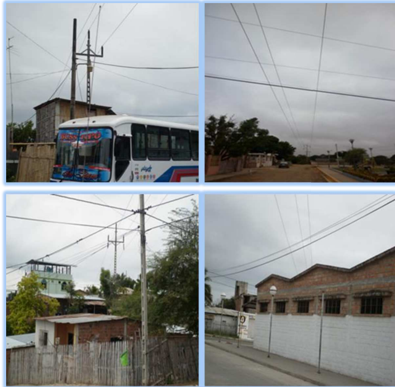
Ilustración 6: Ciudadela Leonidas Proaño- Cantón Montecristi, líneas de 69 KV sobre viviendas y sin respetar franja de servidumbre
