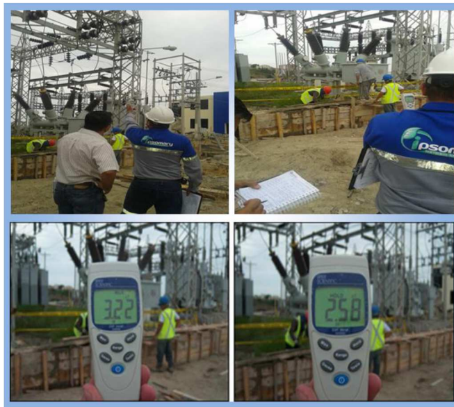
Ilustración 44: Momento de la medición P12. Subestación Manta 1 (530864E-9894144N)
