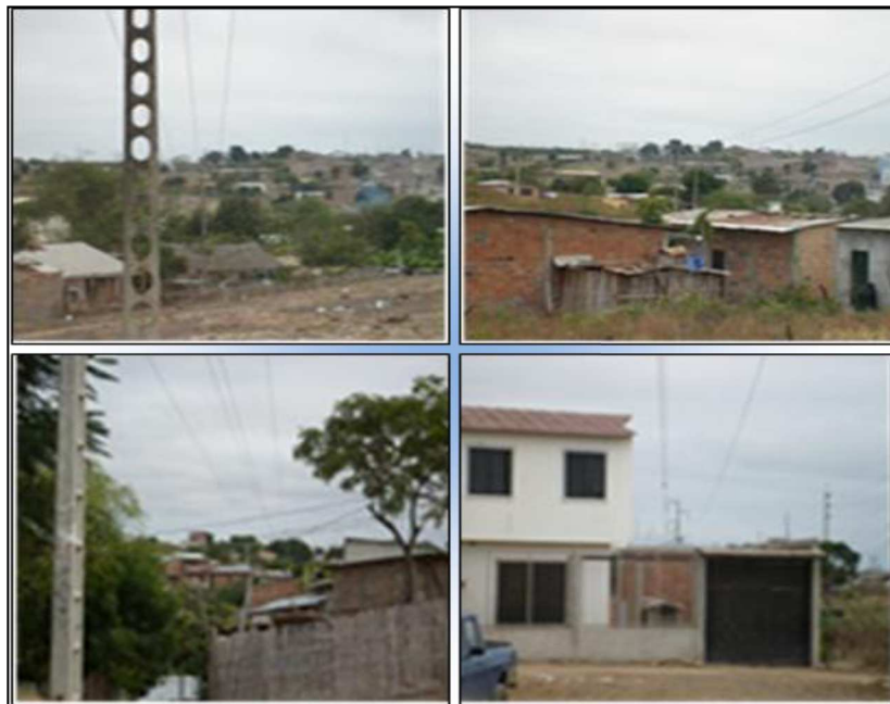
Ilustración 5: Sector Cdla. La Paola- Cantón Montecristi, líneas de 69 KV sobre viviendas y sin respetar franja de servidumbre
