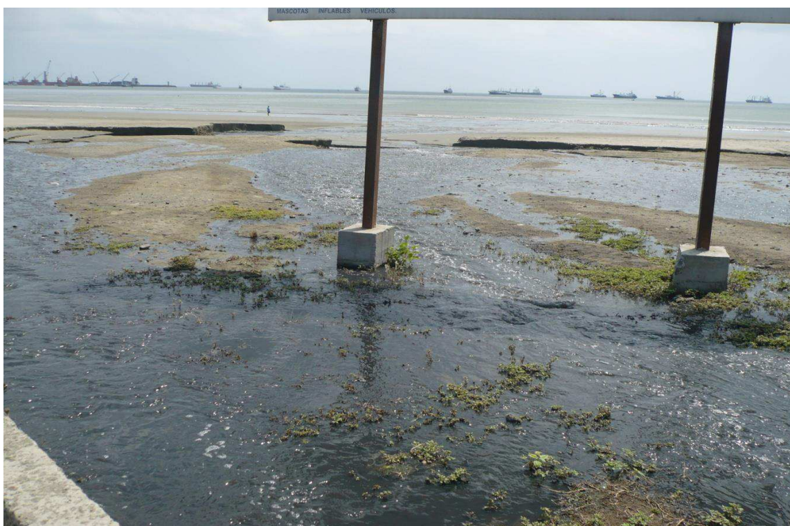
Foto 19. Rebose de aguas servidas de la parroquia Tarqui en la playa en estudio.
