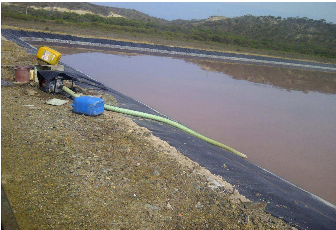
Foto 8. Utilización de las aguas de las lagunas de maduración para fines agrícola en el sector
