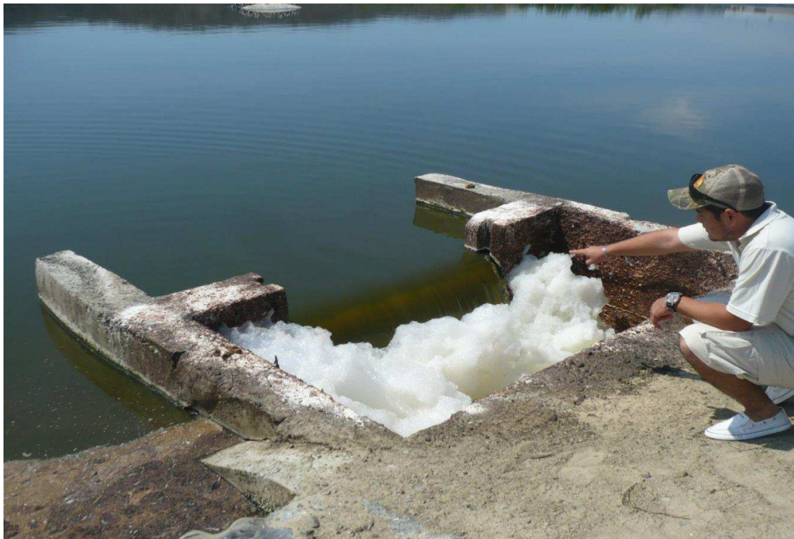
Foto 4. Salida de aguas residuales luego del sistema de lagunaje
