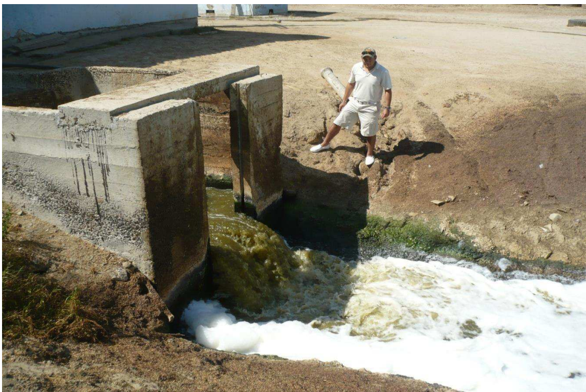
Foto 7. Paso del agua hacia su descarga que la conecta con el Río Manta
