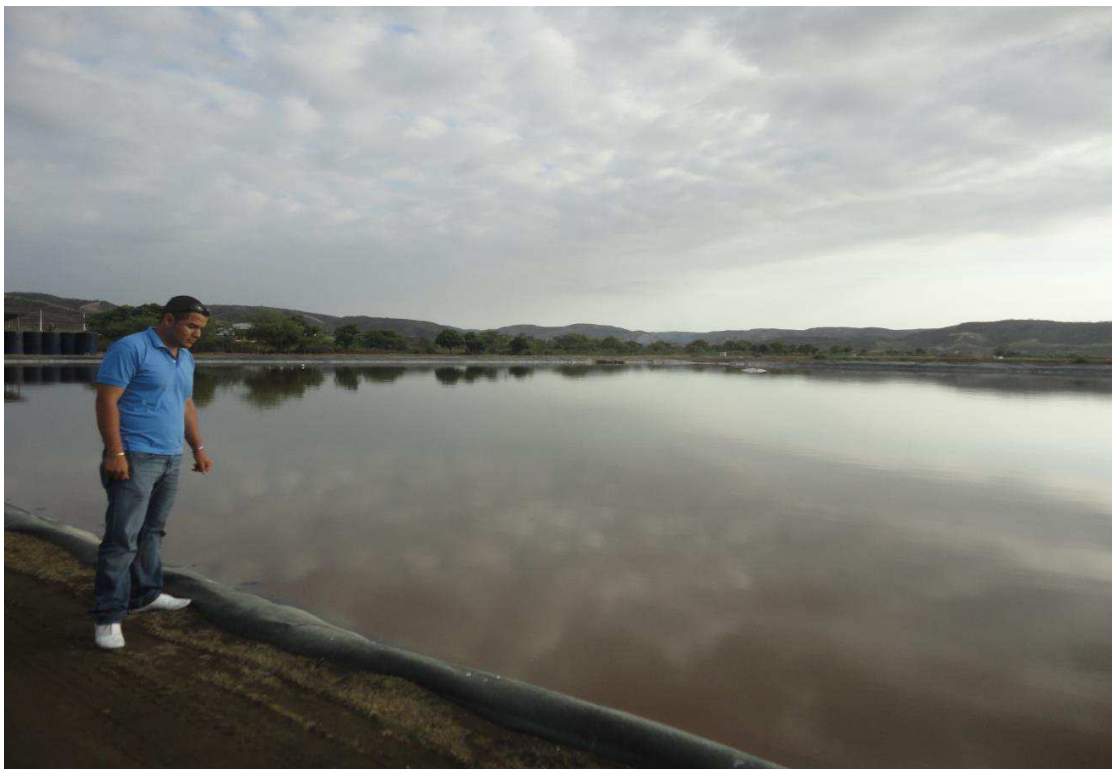
Foto 2. Nuevas lagunas de oxidación construídas en el año 2012-2013
