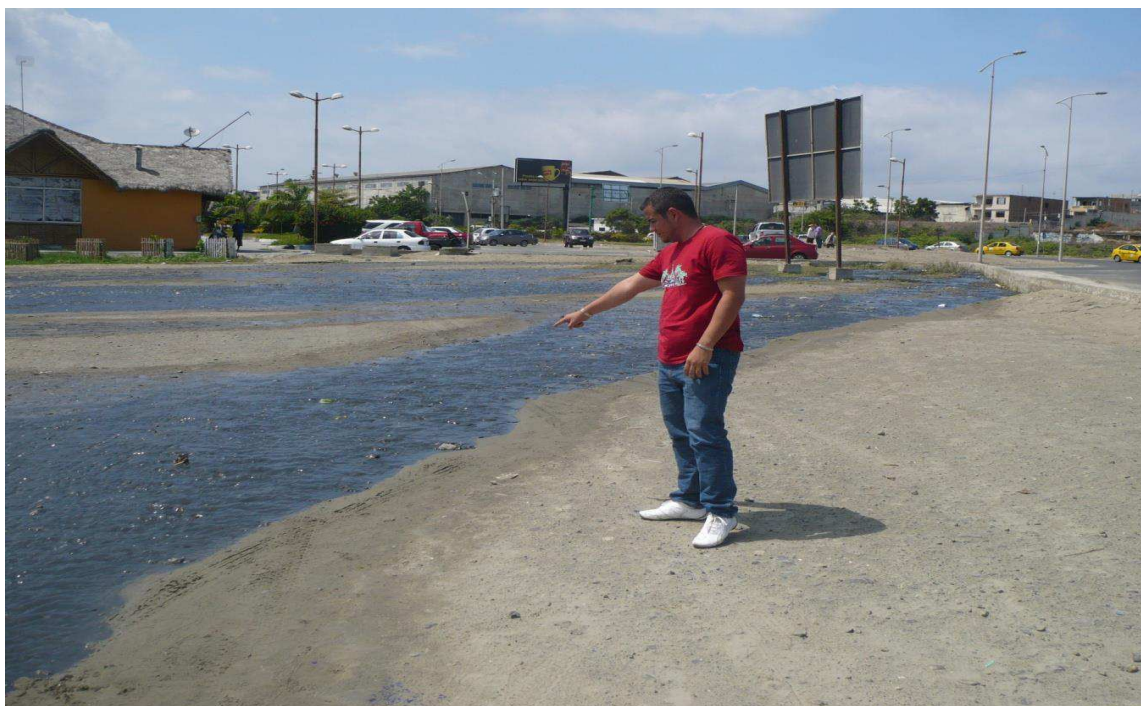
Foto 18. Rebose de aguas servidas de la parroquia Tarqui en la playa en estudio.
