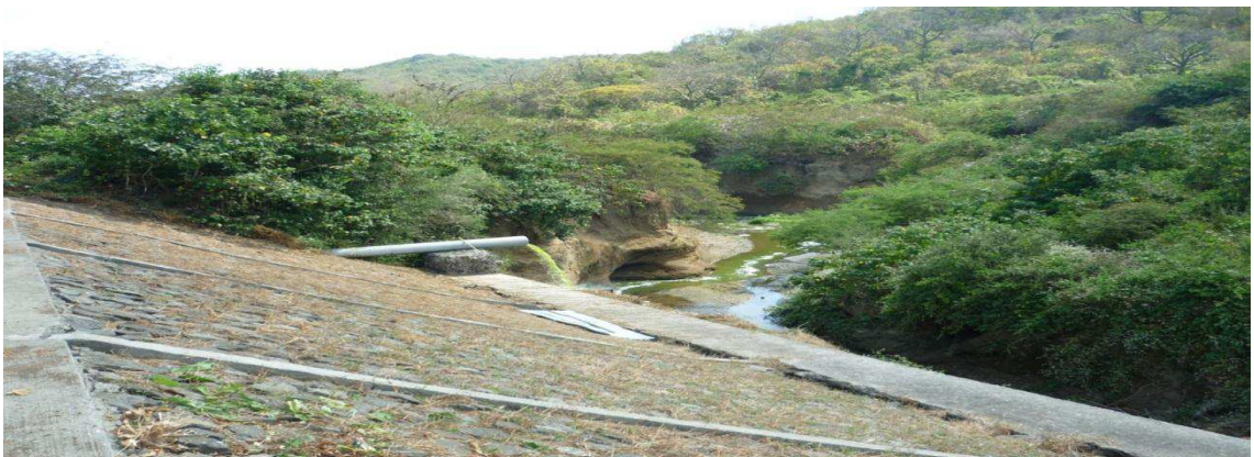
EFLUENTE DE LA LAGUNA DE OXIDACION AGUAS ARRIBA DEL RIO JIPIJAPA
