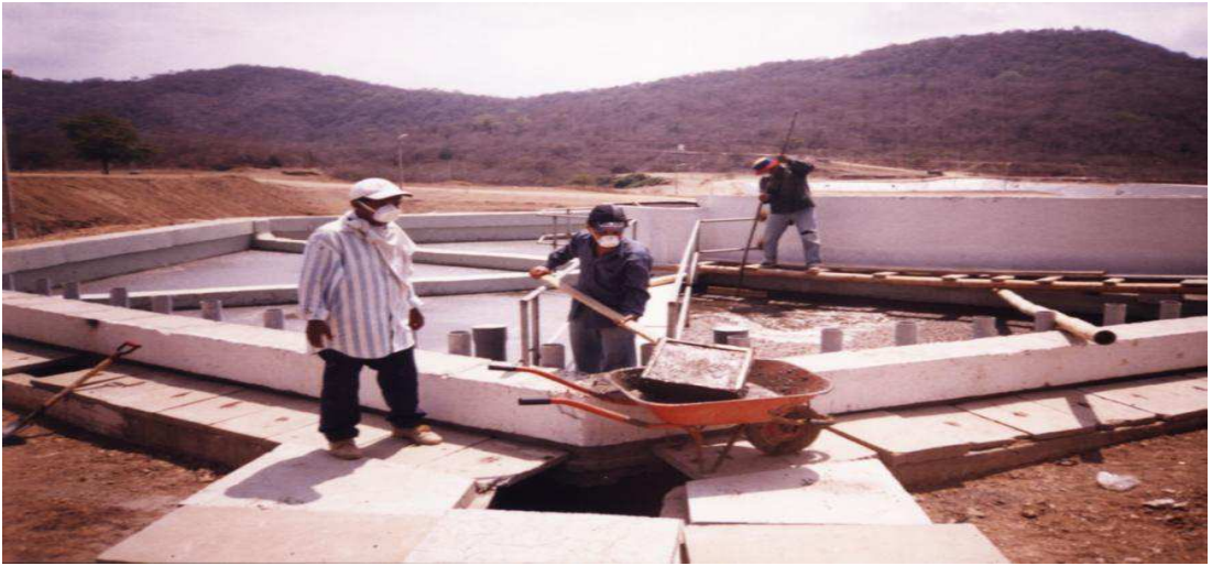
CANALES DE DISTRIBUCIÓN HACIA LAS PISCINAS ANAERÓBICAS CON (BACTERIAS INCORPORADA)
