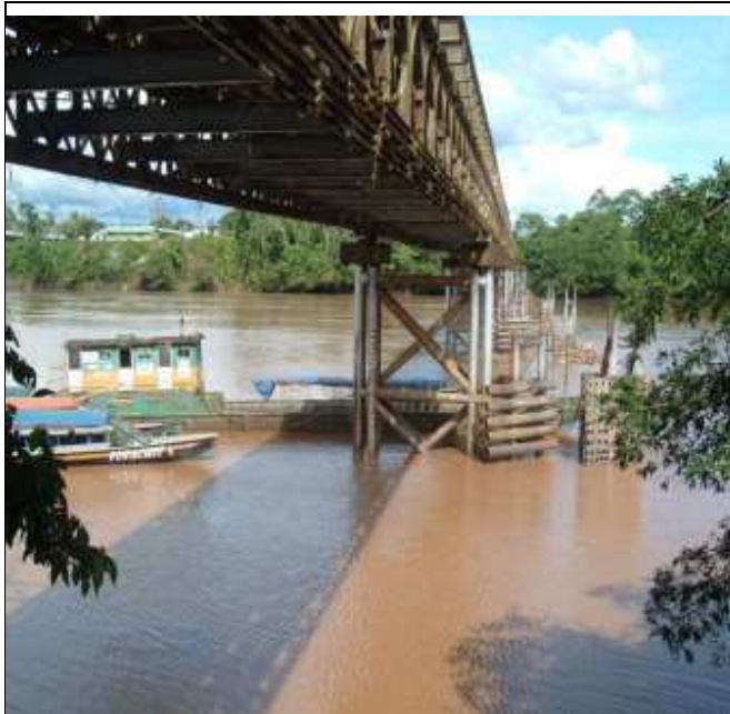
FOTO N 21:AREA DE DESEMBARCO COORDENADA UTM 279116 9949770
