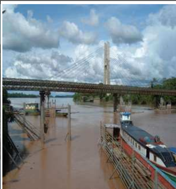
FOTO N 22 : AREA DE DESENBARCO COORDENADA UTM 279116 9949770
