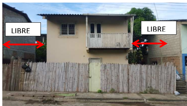
GRÁFICO 104: Mantener los espacios amplios entre viviendas. FUENTE: Investigador
