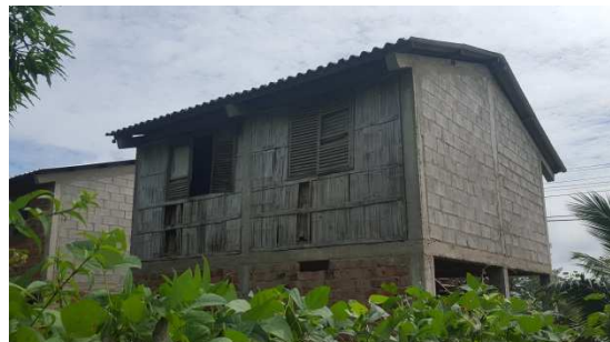
GRÁFICO 63: Paredes de Bloque de Hormigón en los costados y Caña Chancada en los frentes, del diseño original.
