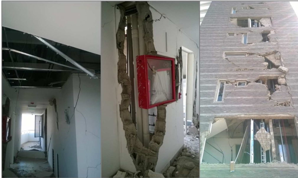
Imagen #16 – Daños en cielo raso, instalaciones y espacato en fachadas.
