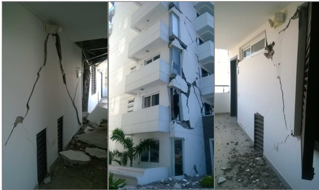
Imagen #15 – Daños en mampostería interna y externa, daños en corredor.
