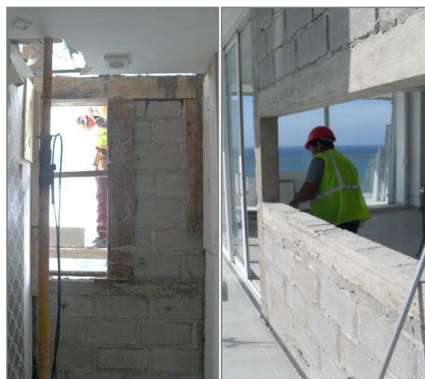
Imagen #19 – Reconstrucción de mampostería con boquetes de ventanas (Fuente y Elaboración: Otto Alvarez)
