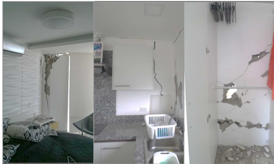
Imagen #9 – Paredes internas y pared externa con grietas.
