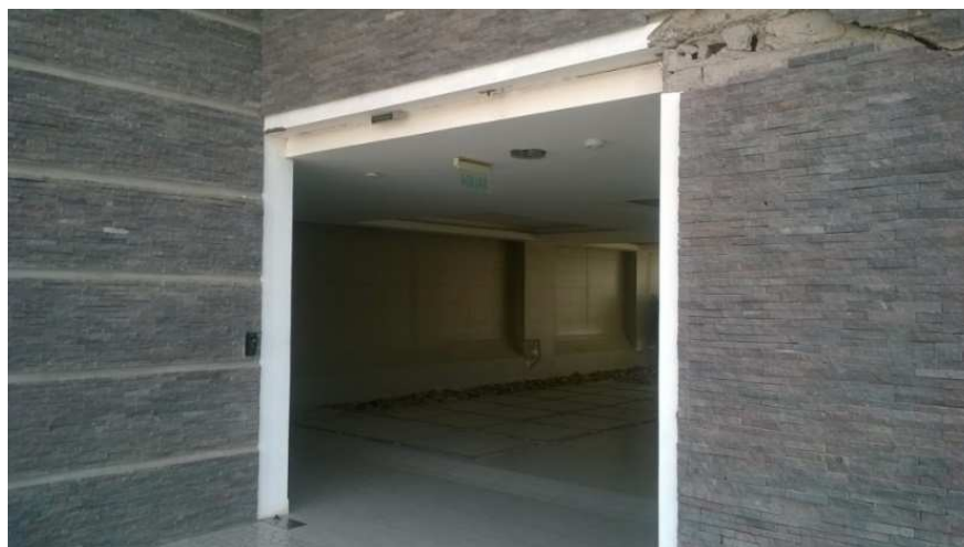
Imagen #12 – Área de lobby sin columnas (Fuente y Elaboración: Otto Alvarez)
