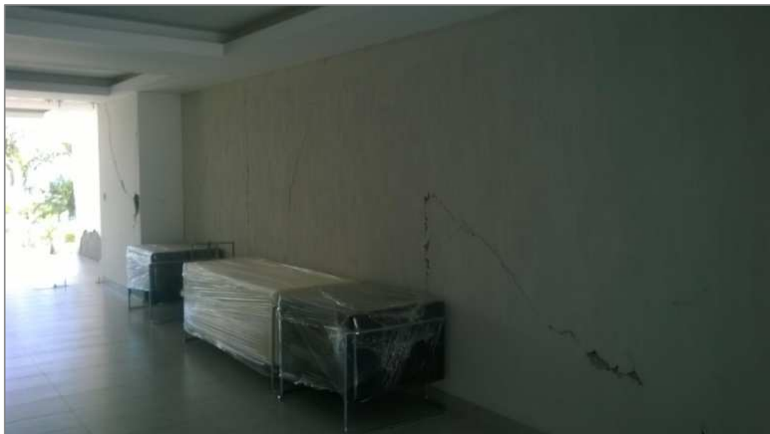
Imagen #13 – Paredes de gran extensión sin soporte central.
