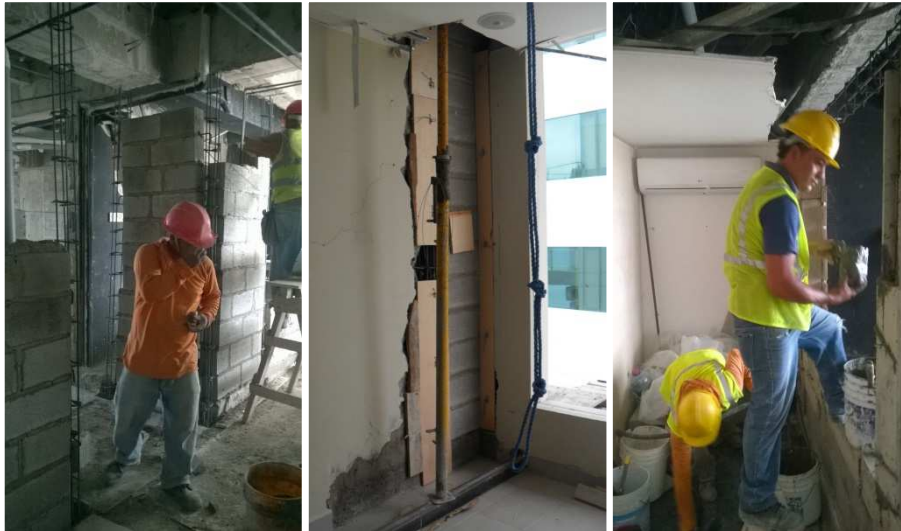
Imagen #18 – Reconstrucción de mampostería interior con columnetas y viguetas
