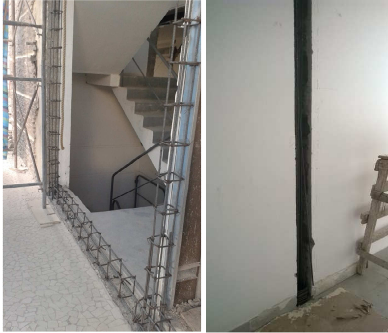
Imagen #21 – Reconstrucción de mampostería en paredes de mayor extensión
