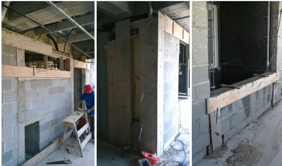
Imagen #17 – Reconstrucción de mampostería exterior y en corredores
