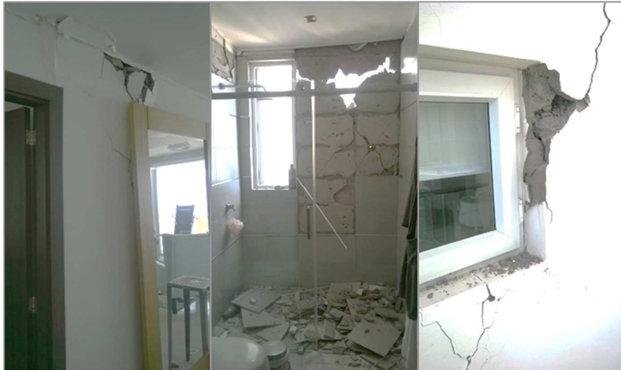
Imagen #10 – Daños en cielo raso, porcelanato y ventanas.
