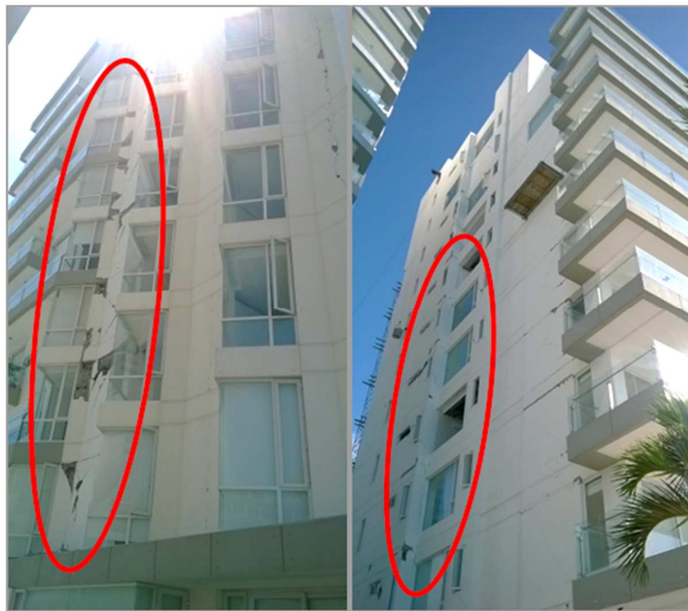
Imagen #5 – Mampostería afectada en esquinas sin soportes.
