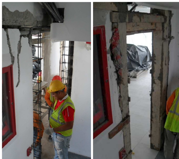
Imagen #20 – Reconstrucción de mampostería con boquetes de puertas
