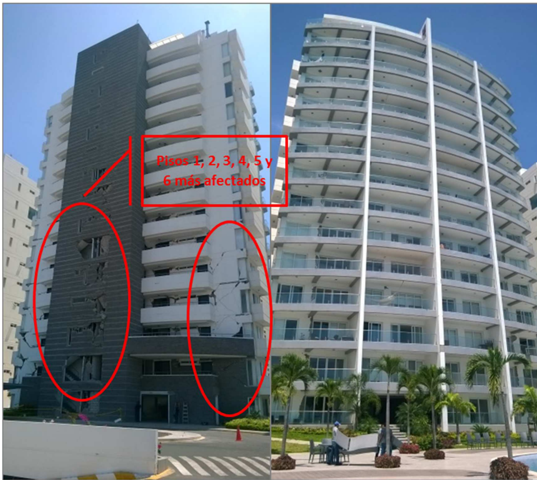
Imagen #6 – Vista frontal y posterior de Torre C luego del 16ª
