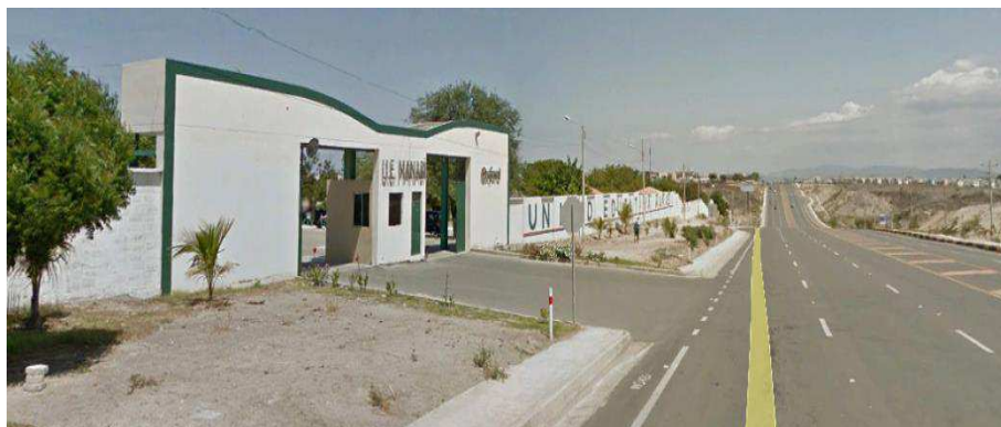
Figura 70: Ingreso Principal Unidad Educativa Manabí desde Vía Manta-San Mateo Fuente: Investigación de Campo Autora: Geomara Cevallos
