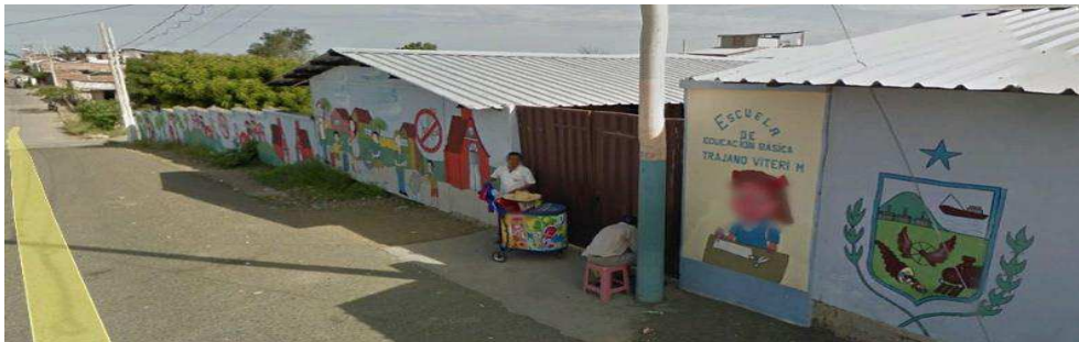
Figura 83: Ingreso Principal Unidad Educativa Trajano Viteri de Manta, Av. 210 y Calle 310 Fuente: Investigación de Campo Autora: Geomara Cevallos
