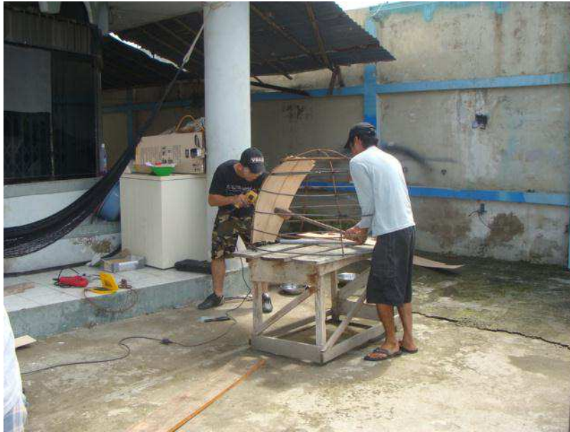
Fotografía 9.1. Etapa de construcción del molde para la estructura (domo)
