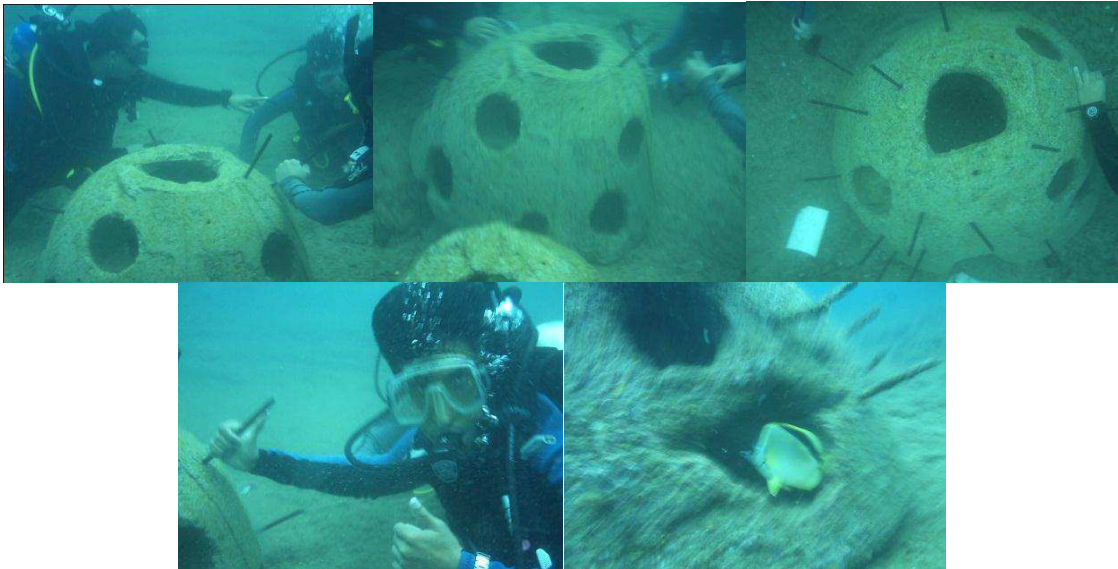
Fotografía 5.2.5.- Ubicación de las varillas de hierro en los domos de concreto (Fuente: Autores de tesis)
