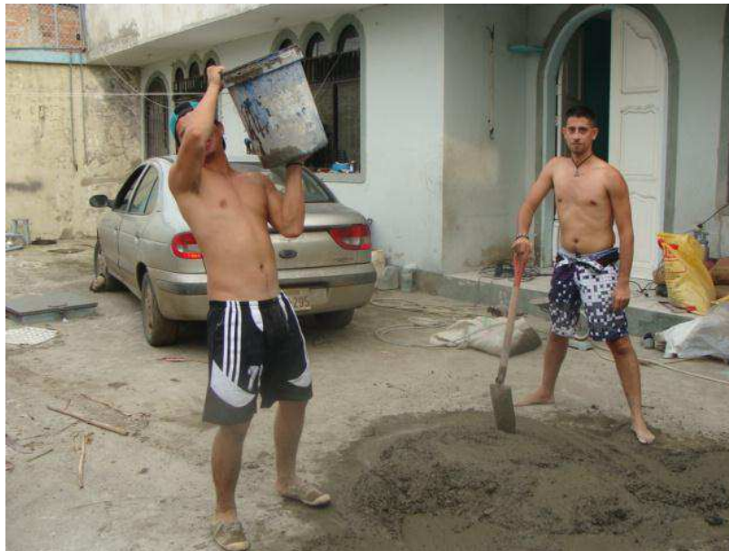
Fotografía 9.2. Fase del concreto a utilizarse en las estructuras (domo)
