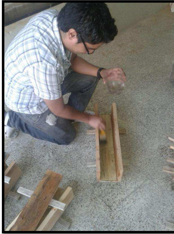
Engrasando el encofrado de viga.
