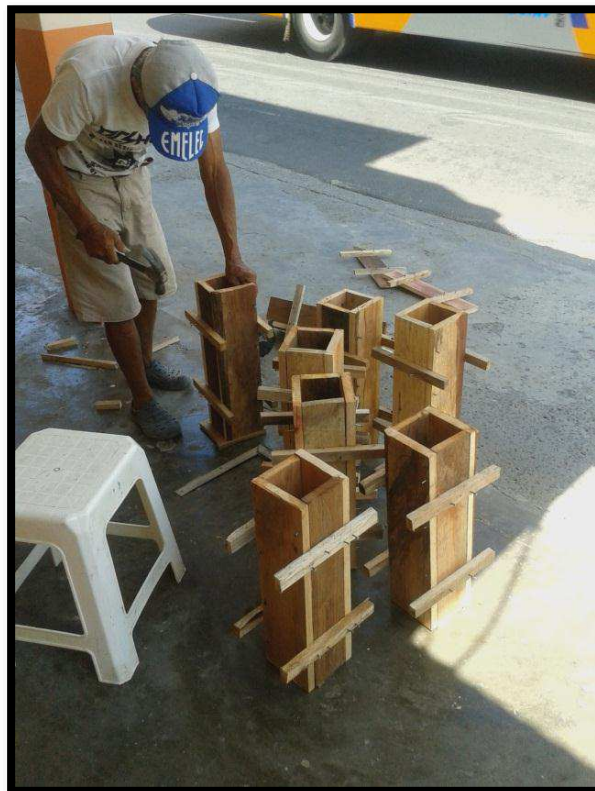
Elaboración de encofrados para las vigas.
