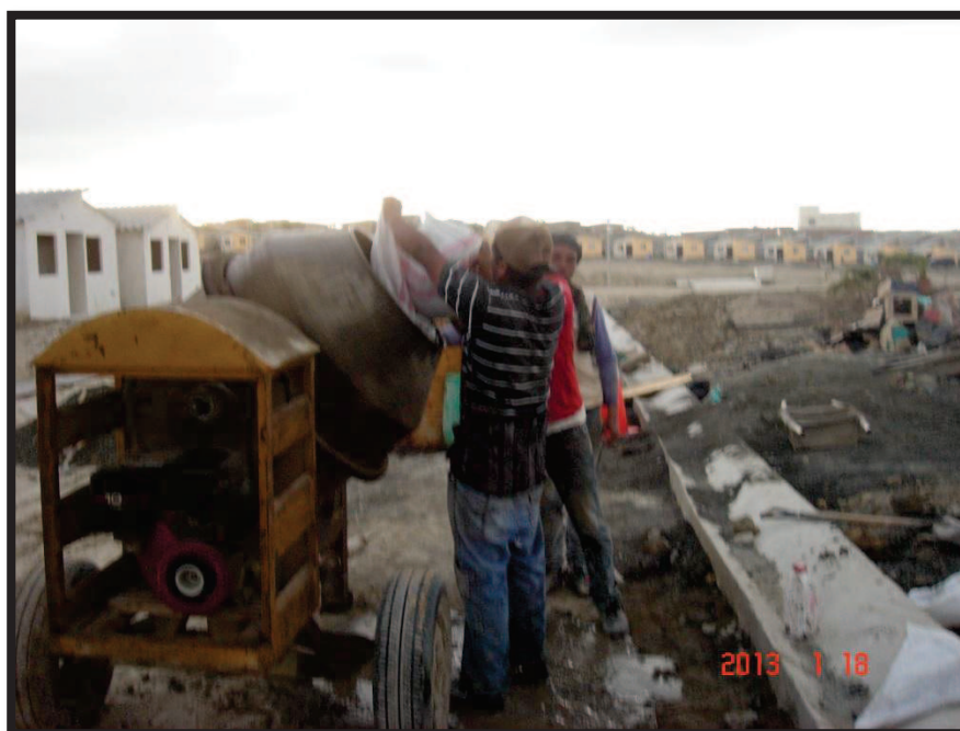
Anexo 20 Preparación de Hormigón.
