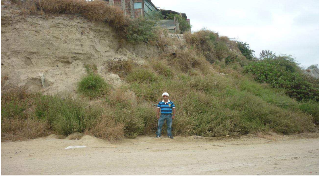
Ilustración 41: Inspección de la zona de estudio previo a la toma de muestra para el análisis en laboratorio Elaborado por: Los Autores
