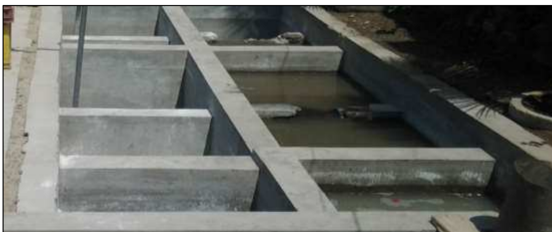
Fig. 7. Proceso de floculación
