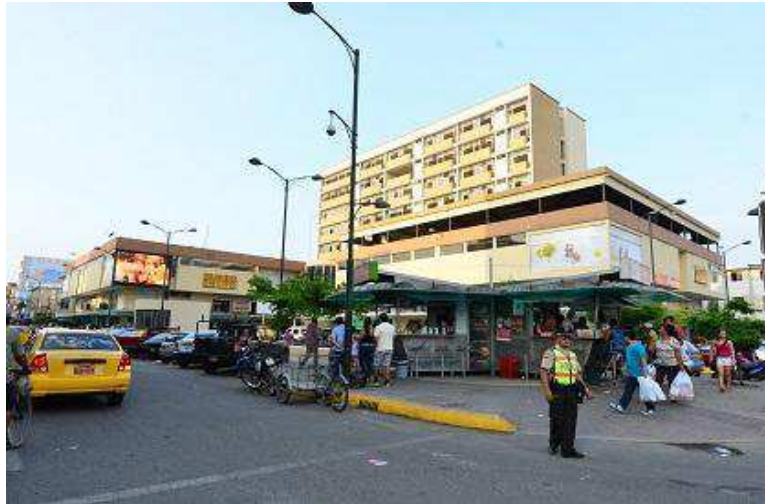
Figura 1 Edificio del Centro Comercial Municipal de Portoviejo, que establece la zona del centro comercial antes de terremoto suscitado el 16A en el Ecuador.
