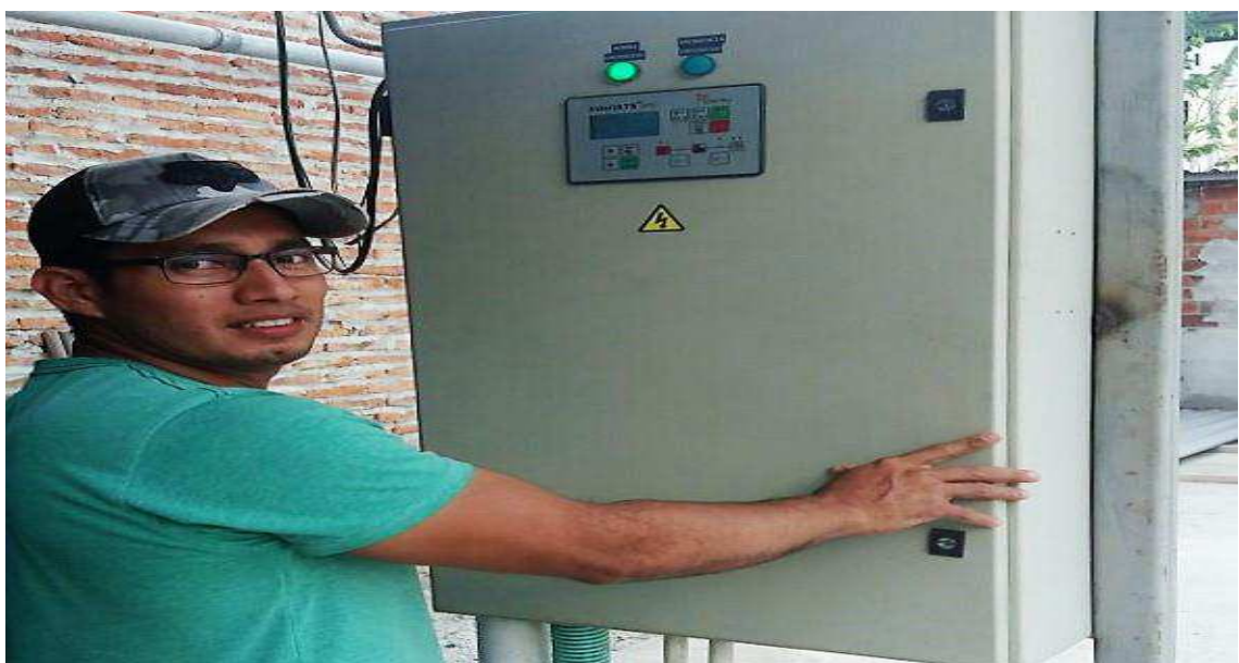
Figura N° 12: Tablero de control automático
