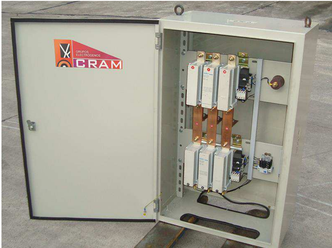
Figura 2: Tablero en construcción
