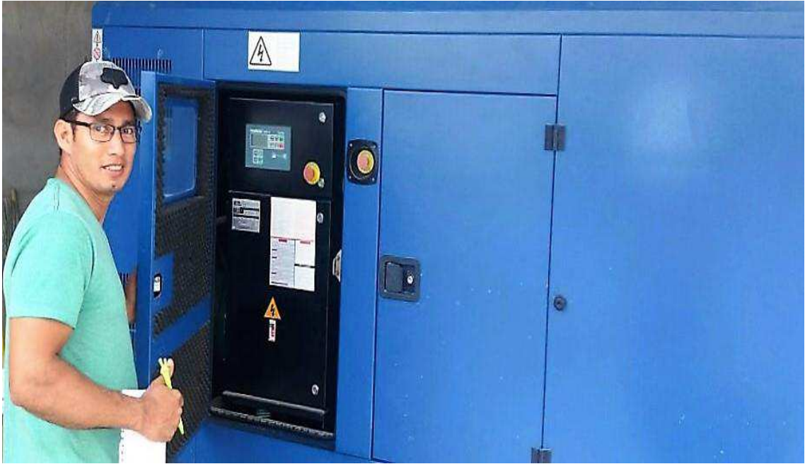
Figura N° 9: Tablero del generador
