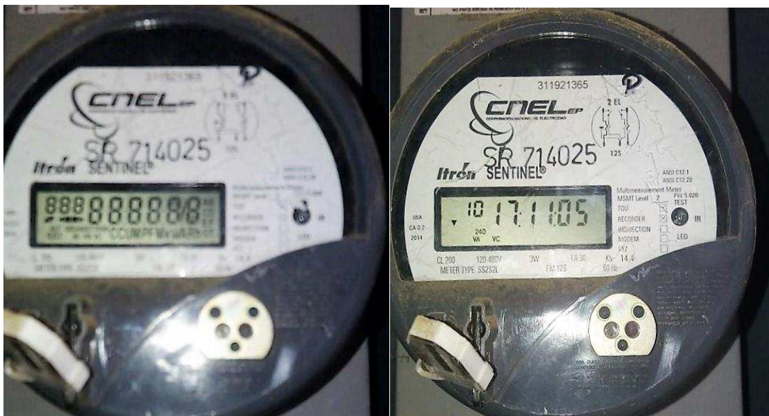
Figura N° 13: medidores de control
