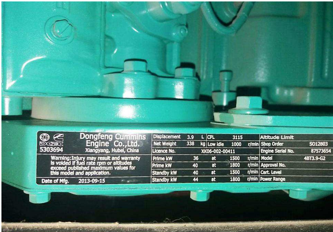
Figura N° 8: Grupo electrógeno del Hospital Básico Tosagua
