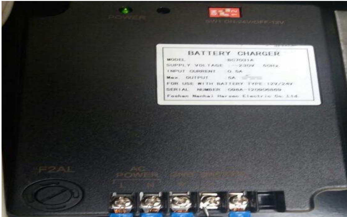
Figura N° 11: cargador de batería
