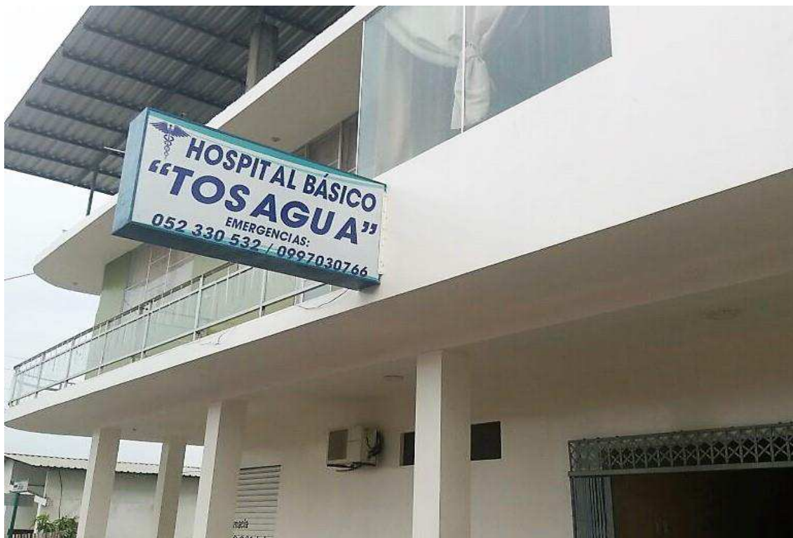
Edificio Hospital Básico Tosagua
