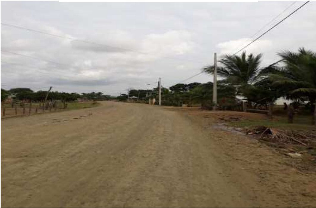
Instalación Eléctrica actual del Alumbrado Publico
