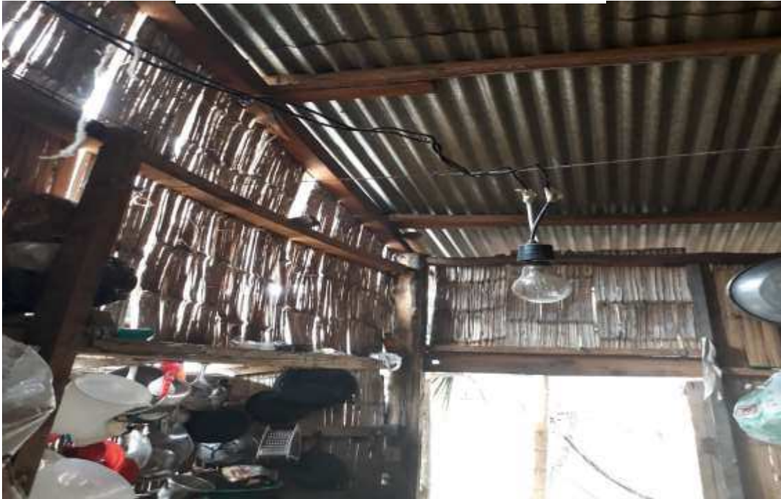
Instalación Eléctrica actual de las viviendas
