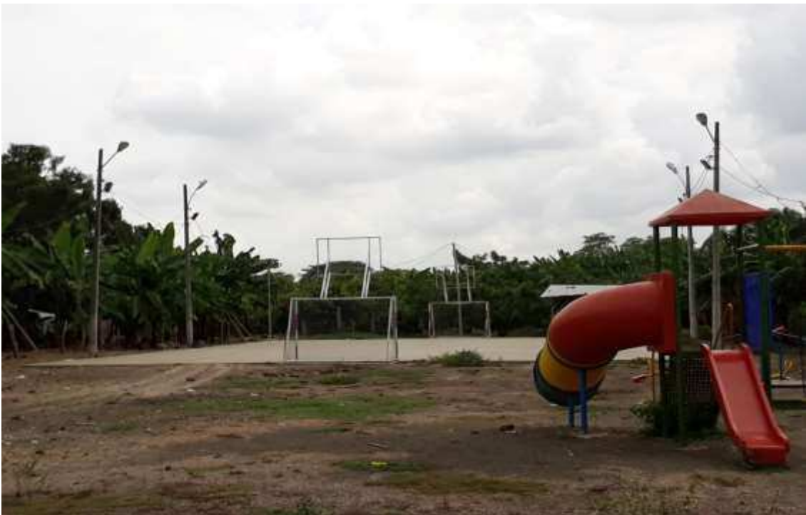
Instalación Eléctrica actual del Alumbrado Publico
