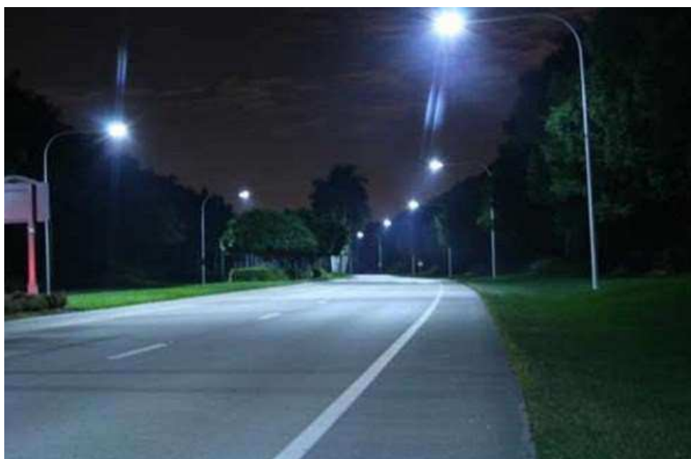
Figura 6 Vialidad iluminada con luminarios para alumbrado público con un módulo de 64 LEDs con potencia de 110W.
