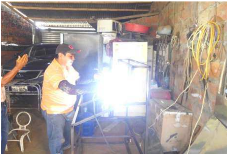
Trabajando en soldaduras
