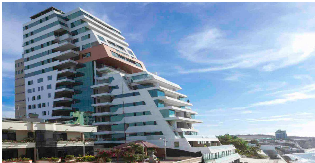
Figura 8. Fotografía del edificio Hotel Poseidón
