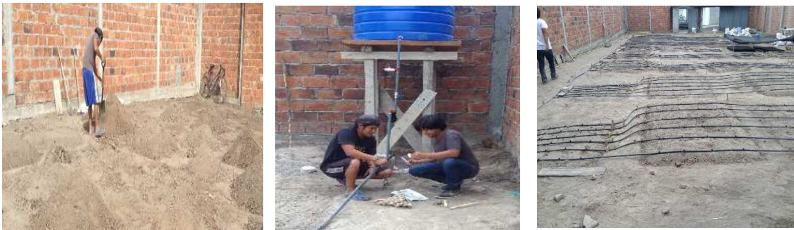
Foto 4,5 y 6: incorporación del estiércol bovino, elevación del tanque e instalación del sistema de riego.
