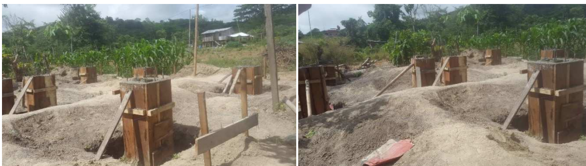
Figura 68: Colocación de puntales o diagonales en el encofrado. Fuente: Investigación de campo – Investigador – CISP.
