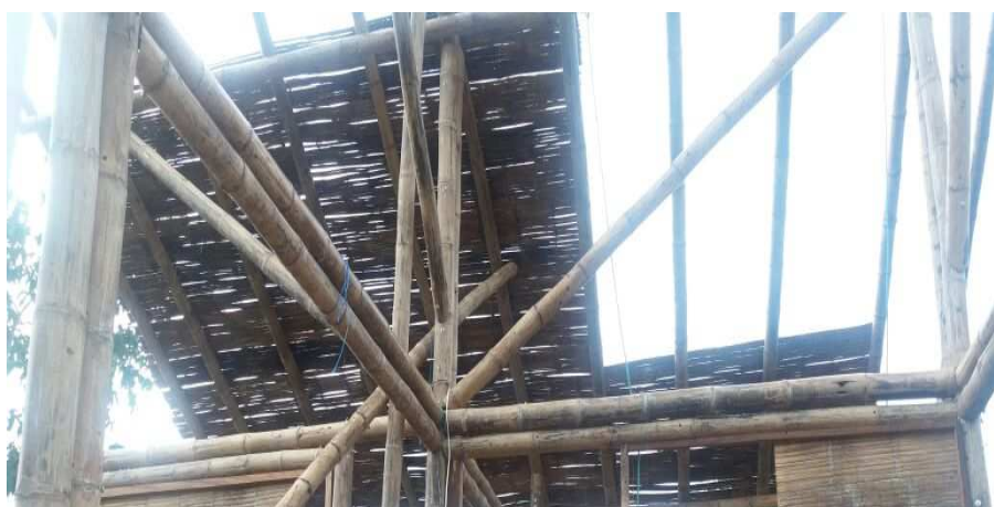
Figura 83: Colocación caña chancada. Fuente: Investigación de campo – Investigador – CISP.
