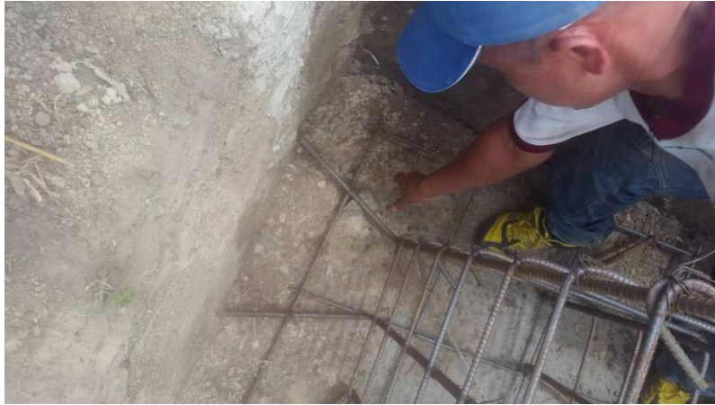
Figura 64: Amarre de parrilla con la estructura de plinto. Fuente: Investigación de campo – Investigador – CISP.
