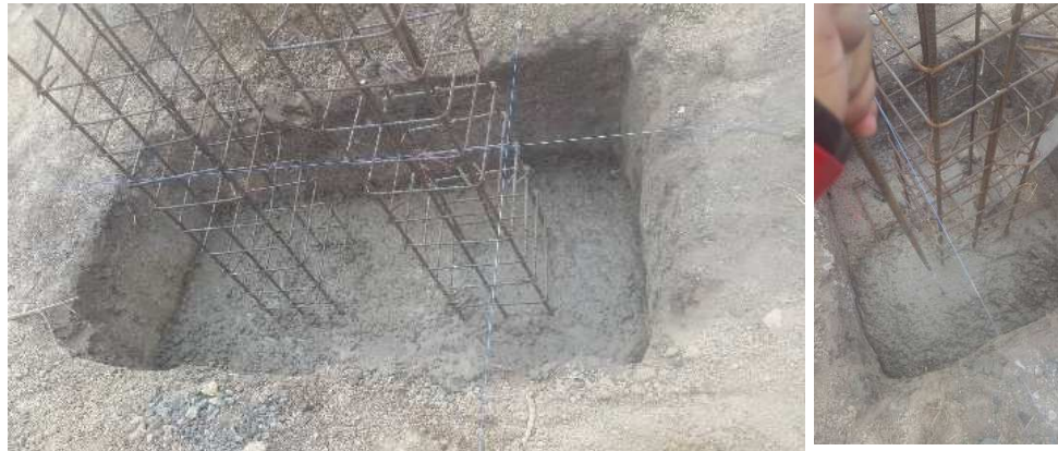
Figura 65: Colocación de capa de hormigón. Fuente: Investigación de campo – Investigador – CISP.
