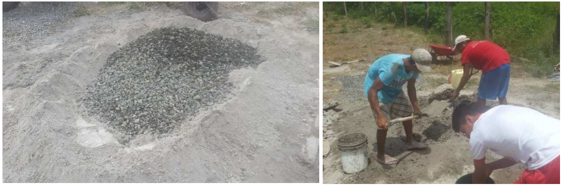
Figura 65: Mezcla de concreto en el sitio. Fuente: Investigación de campo – Investigador – CISP.
