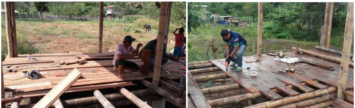
Figura 75: Colocación madera para piso. Fuente: Investigación de campo – Investigador – CISP.
