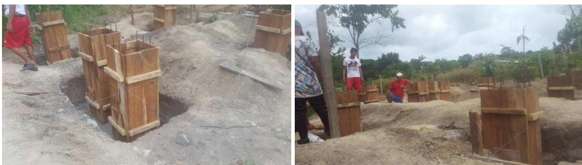
Figura 67: Colocación de encofrados en el terreno. Fuente: Investigación de campo – Investigador – CISP.
