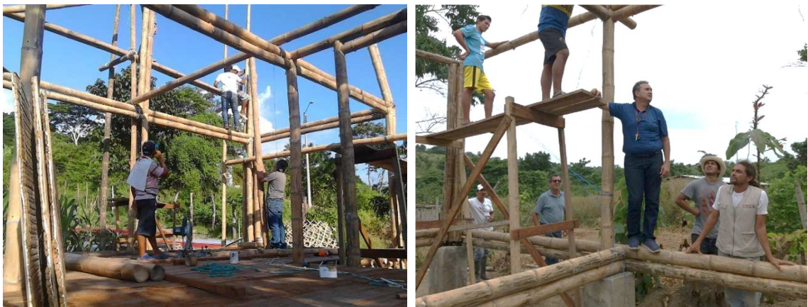
Figura 79: Elevamiento de la estructura. Fuente: Investigación de campo – Investigador – CISP.
