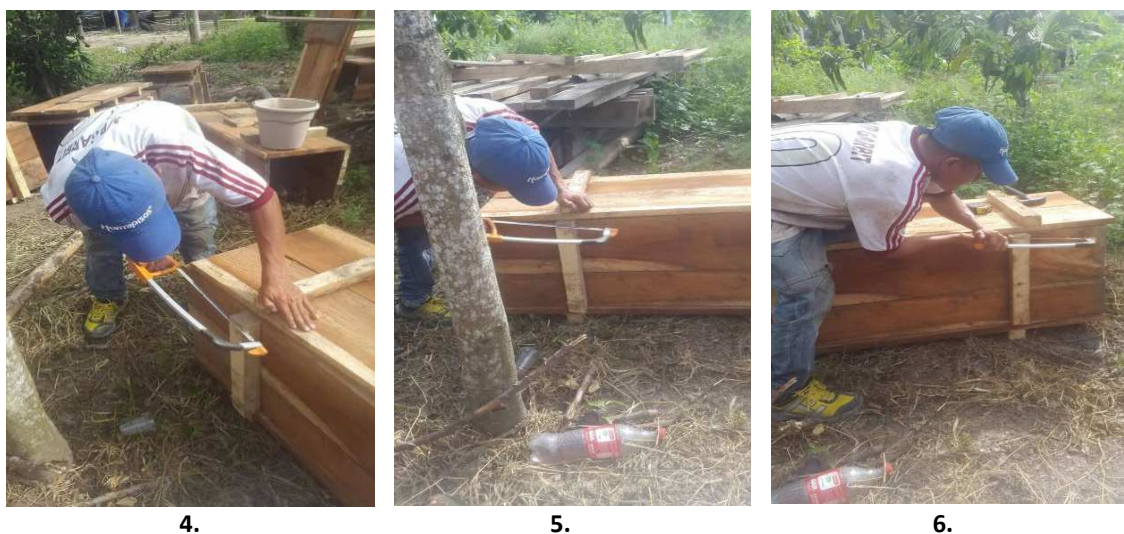
Figura 62: Fabricación de encofrado para plinto. Fuente: Investigación de campo – Investigador – CISP.
