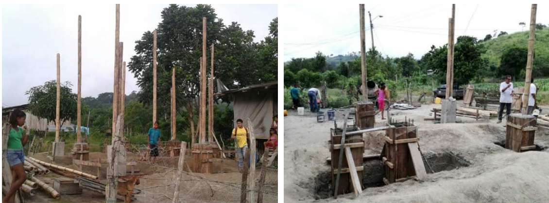
Figura 72: Colocación de todas las columnas y desencofrado. Fuente: Investigación de campo – Investigador – CISP.
