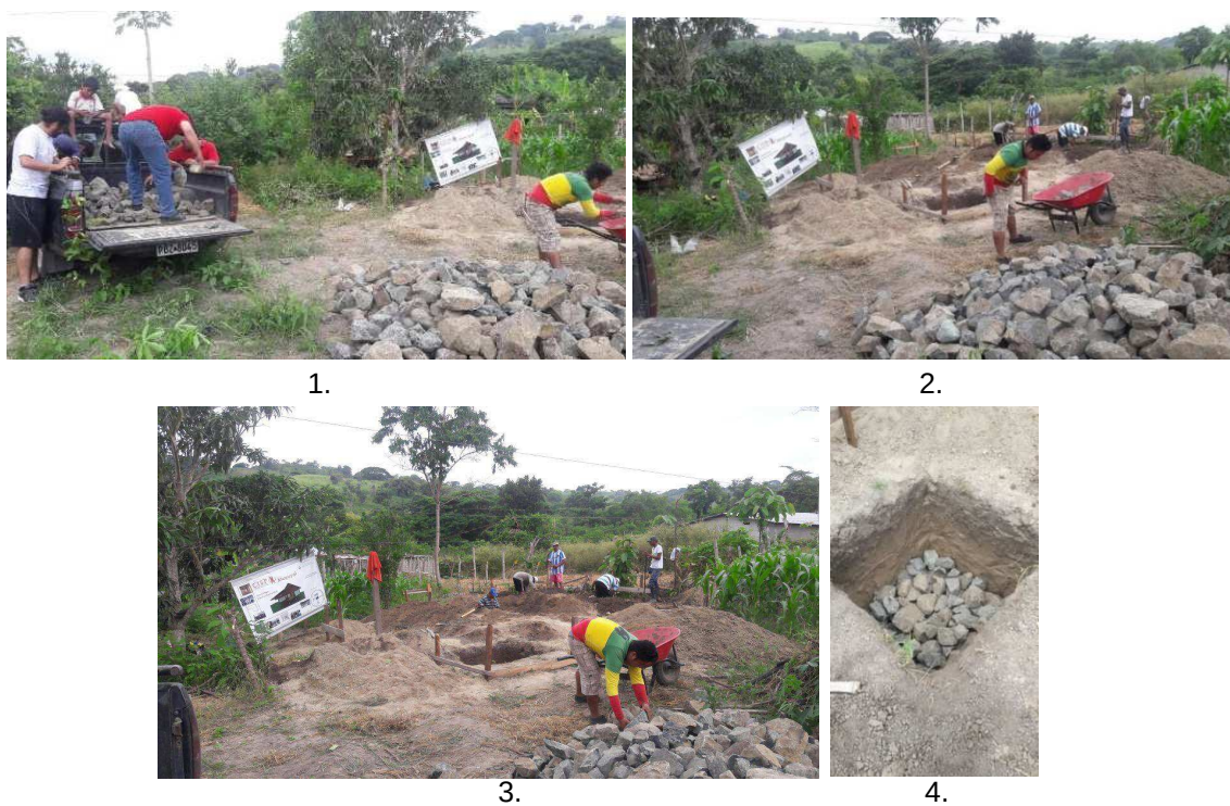
Figura 59: Llegada y colocación de piedra bola. Fuente: Investigación de campo – Investigador – CISP.
