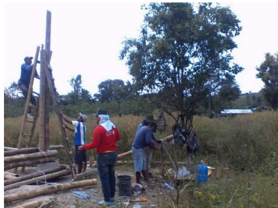
Figura 78: Montaje de estructura sobre cimientos. Fuente: Investigación de campo – Investigador – CISP.
