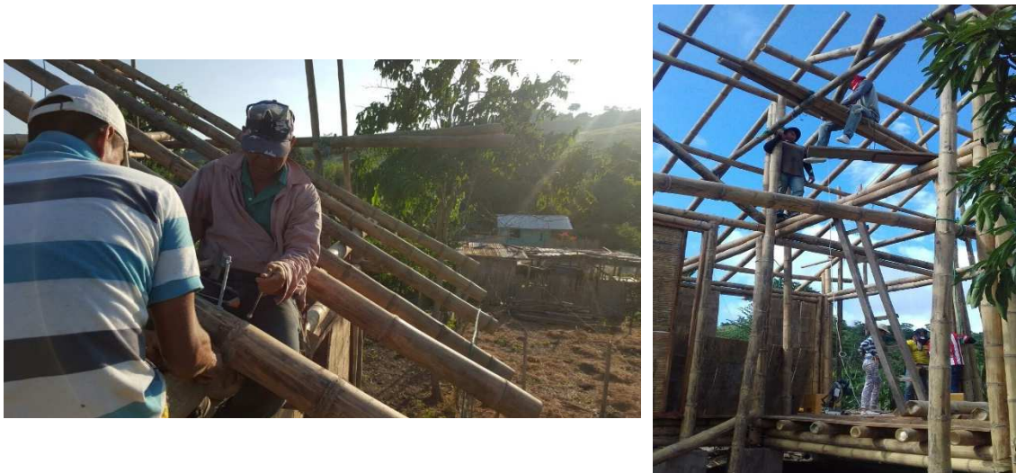
Figura 82: Colocación amarres y anclajes. Fuente: Investigación de campo – Investigador – CISP.
