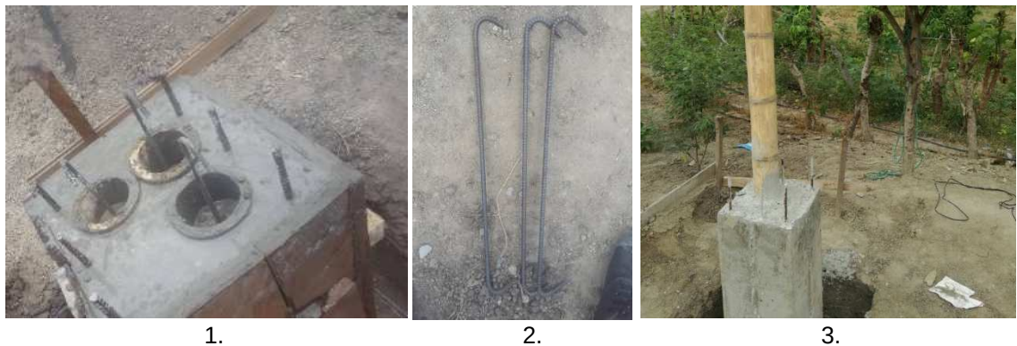
Figura 70: Colocación de gancho y colocación de columna. Fuente: Investigación de campo – Investigador – CISP.
