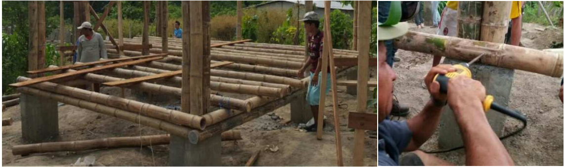
Figura 74: Colocación de vigas para piso y amarres. Fuente: Investigación de campo – Investigador – CISP.
