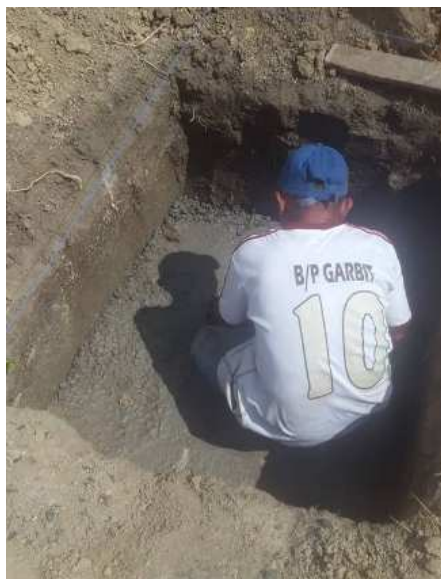
Figura 61: Colocación de capa de hormigón simple. Fuente: Investigación de campo – Investigador – CISP.
