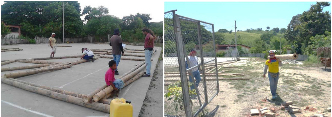
Figura 77: Pre-elaboración de elementos en el suelo y traslado del material. Fuente: Investigación de campo – Investigador – CISP.
