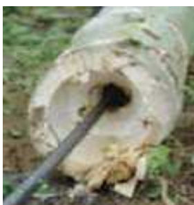
1. Perforar los tabiques internos.
