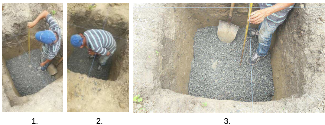
Figura 60: Colocación de capa de ripio. Fuente: Investigación de campo – Investigador – CISP.
