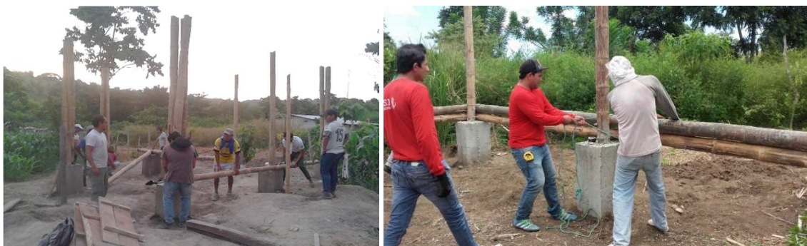
Figura 73: Colocación de vigas para piso y amarres. Fuente: Investigación de campo – Investigador – CISP.
