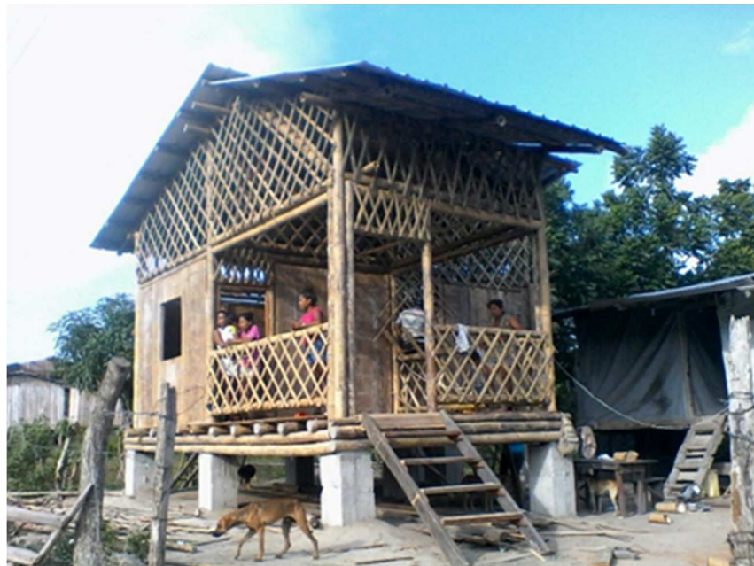
Figura 32: Vivienda Terminada. Fuente: CISP – ULEAM.
