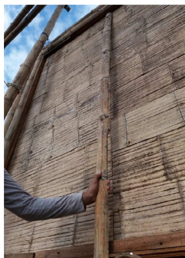
Tira de caña para cubrimiento de unión entre paneles.
