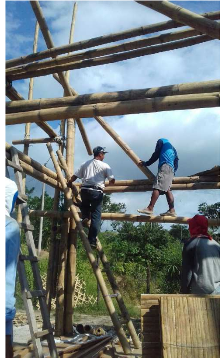
Figura 80: Colocación de estructura para el techo Fuente: Investigación de campo – Investigador – CISP.
