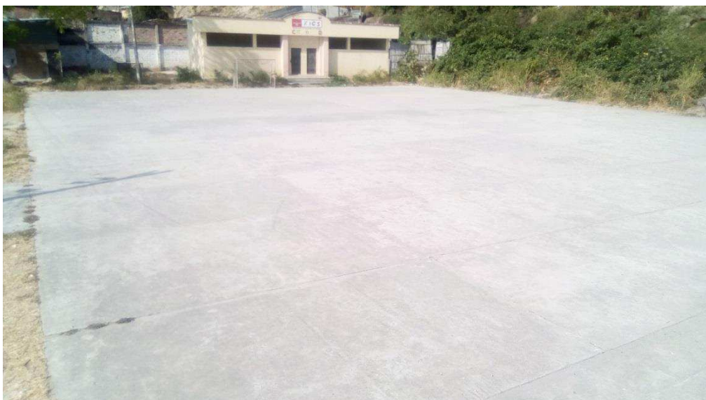
Figura 24 Cancha de uso Múltiple del sector Fuente: Elaborada por el Autor
