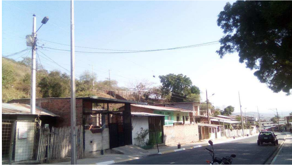
Figura 28 Tendido Eléctrico. Postes nuevos sin Funcionar Fuente: Elaborada por el Autor
