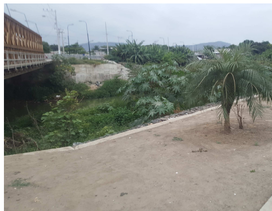
Gráfico 29. Implementación de muros de gaviones.
