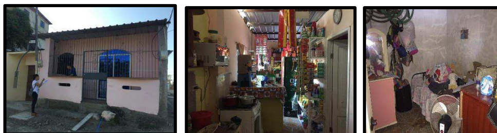
Imagen No. 2: situación actual – fachada frontal e interior de la vivienda FUENTE: Elaboración propia
