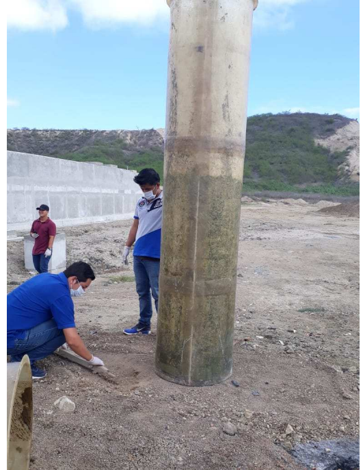
Foto 2. Nivelación del recipiente de 2,5 metros de profundidad.
