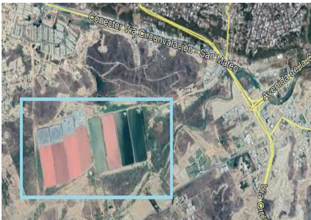
Ilustración 2.1. Vista aérea de la planta de tratamiento de aguas residuales de Manta
