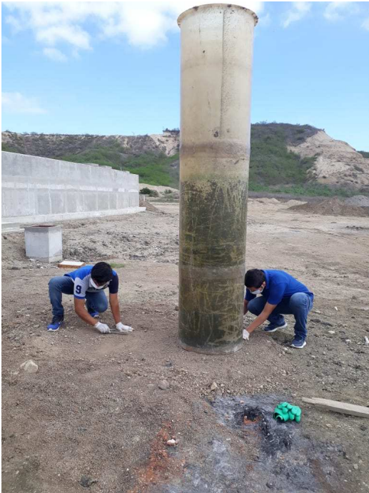
Foto 1. Nivelación del recipiente de 2,0 metros de profundidad.
