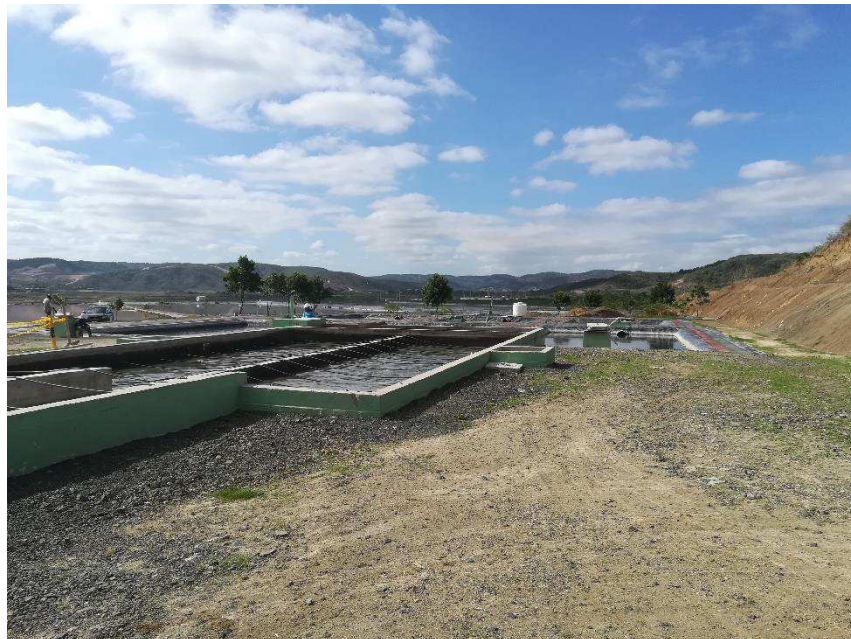
Foto 3. Cárcamo Receptor de las aguas servidas de la ciudad de Manta.
