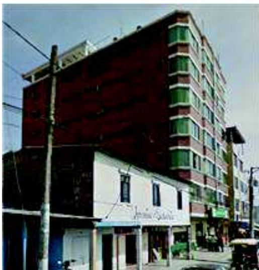
Ilustración II-5 Muros diafragma en la estructura. Fuente: Autores
