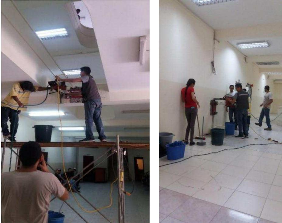
Figura 42. Extracción de núcleo de los elementos seleccionados;
