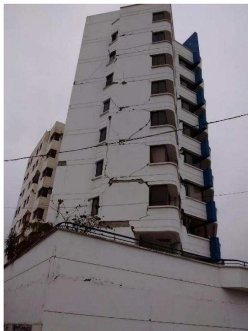
Figura 9. Vulnerabilidad no Estructural, daño de mampostería sin afectar a elementos estructurales;
