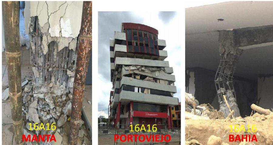
Figura 8. Vulnerabilidad Estructural; edificios afectados por el terremoto del 16A.
