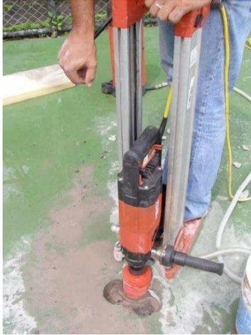
Figura 28. Extracción del núcleo de hormigón;
