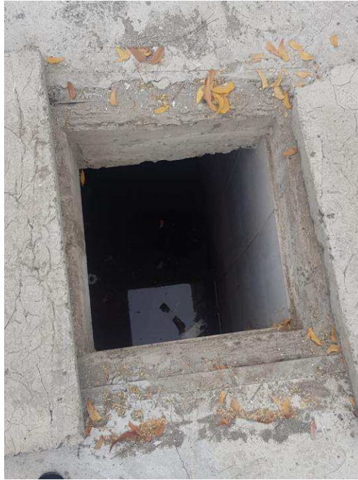
Ilustración 3: Estado actual de la cisterna
