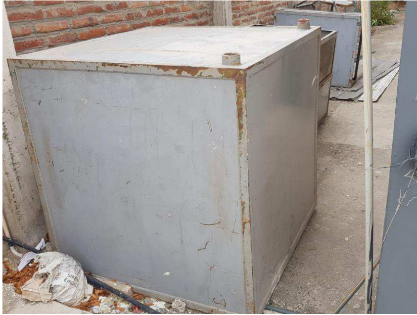
Ilustración 5: Estado actual del tanque elevado
