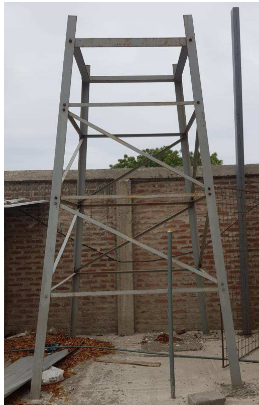
Ilustración 4: Estructura metálica del tanque elevado
