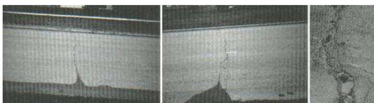
**Figura 18** De izquierda a derecha, Grietas longitudinales / transversales de baja, media y alta severidad.
