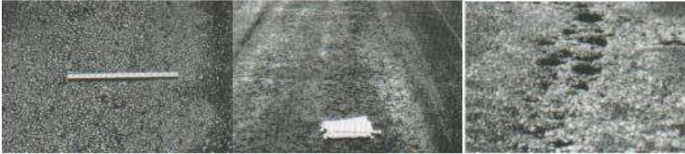
*Figura 27 De izquierda a derecha, Falla por desprendimiento de agregados de baja, media y alta severidad.*
