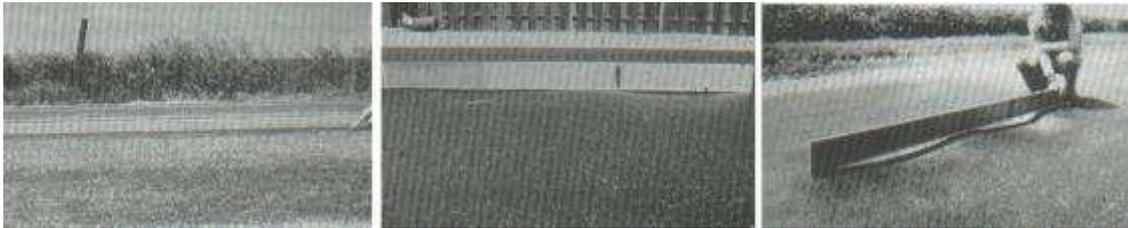
*Figura 13 De izquierda a derecha, Falla por corrugación de baja, media y alta severidad.*
