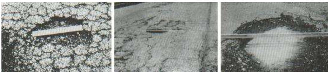
**Figura 21** De izquierda a derecha, Falla por huecos de baja, media y alta severidad.
