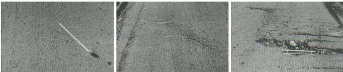
**Figura 25** De izquierda a derecha, Falla por grietas parabólicas, media y alta severidad.
