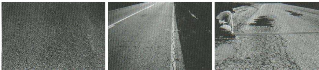
*Figura 9 Falla de piel de cocodrilo de baja, media y alta severidad*
