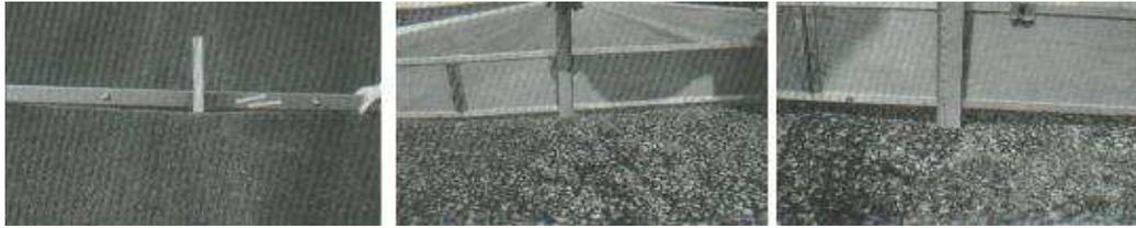
**Figura 23** De izquierda a derecha, Falla por ahuellamiento de baja, media y alta severidad.
