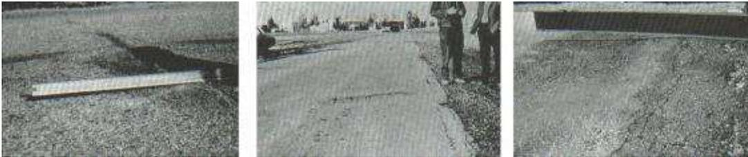
*Figura 12 De izquierda a derecha, Falla por abultamiento y hundimientos de baja media y alta severidad*
