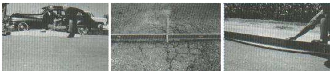
*Figura 14 De izquierda a derecha, Falla por depresión de baja, media y alta severidad.*
