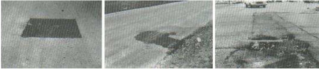
**Figura 19** De izquierda a derecha, Parches y acometidas de baja, media y alta severidad.
