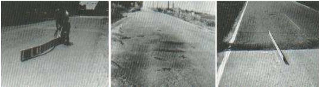
*Figura 24 De izquierda a derecha, falla por desplazamiento de baja, media y alta severidad.*
