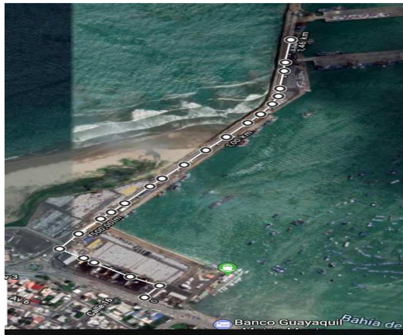
Figura 30. Tramo soterrado desde el borde del patio 300 hasta la cabecera de los muelles. Fuente: el autor.
