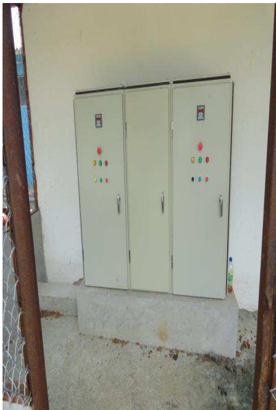
Figura N° 3.19: Tablero de control bombas presedimentadores nos. 1 y 2 - 50 HP
