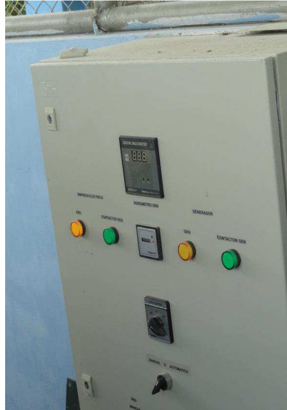
Figura N° 3.9: Tablero de transferencia transformador T06e
