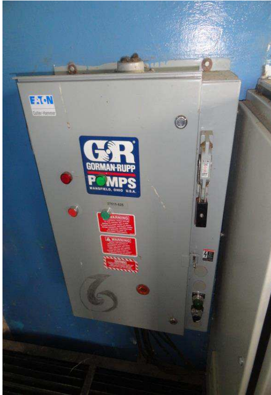
Figura N° 3.18: Tablero de control bomba agua cruda N° 7-60 HP
