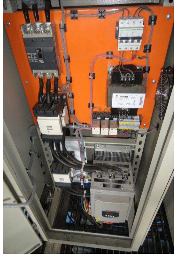
Figura N° 3.16: Tablero de control bomba agua cruda N° 5-87 HP
