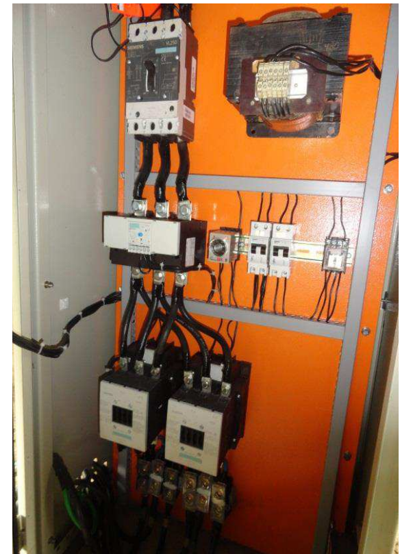
Figura N° 3.13: Tablero de control bomba agua cruda N° 2-150 HP
