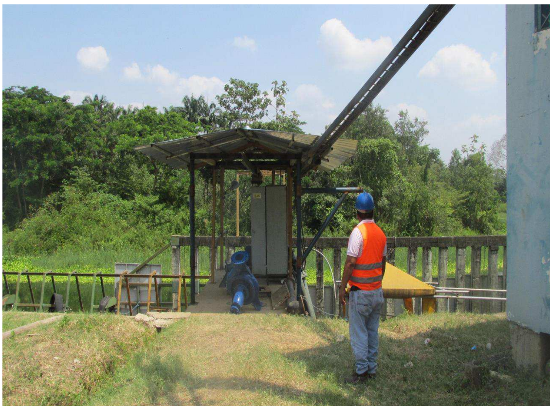
Caseta de bomba de la captación de agua cruda
