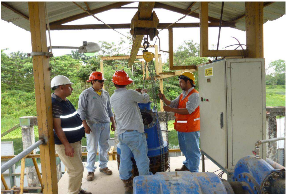
Investigadores Julio Bravo y Edison Cevallos participando de un montaje de bomba de agua
