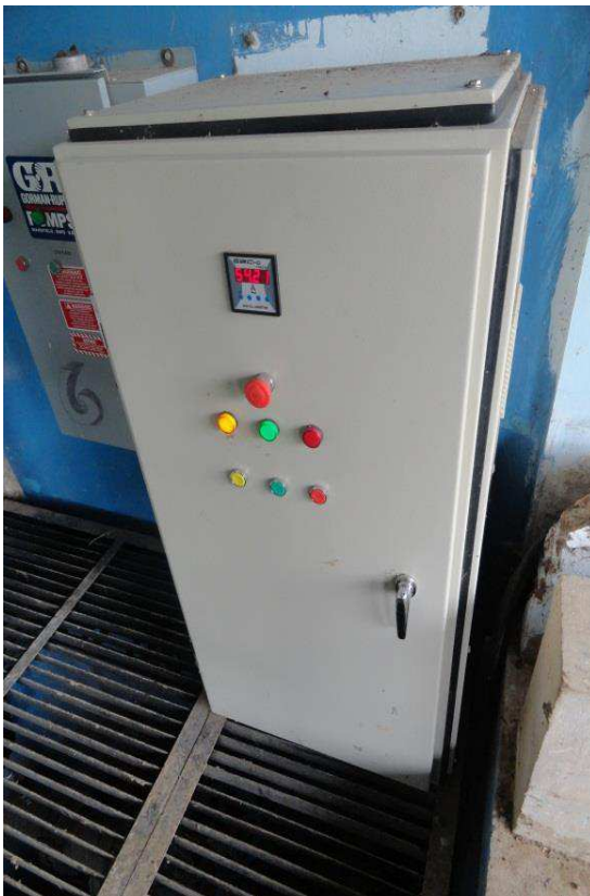
Figura N° 3.17: Tablero de control bomba agua cruda N° 6-87 HP
