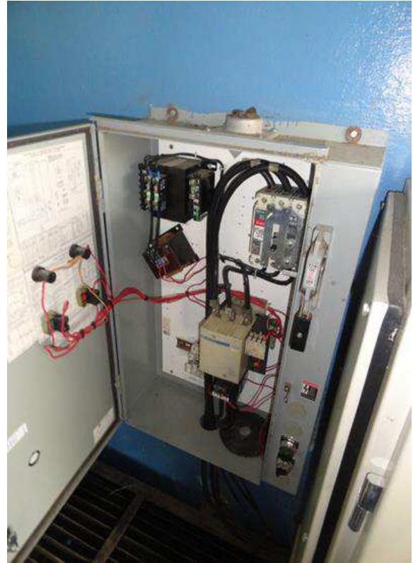
Figura N° 3.18: Tablero de control bomba agua cruda N° 7-60 HP
