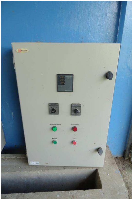
Figura N° 3.14: Tablero de control bomba agua cruda N° 3-60 HP
