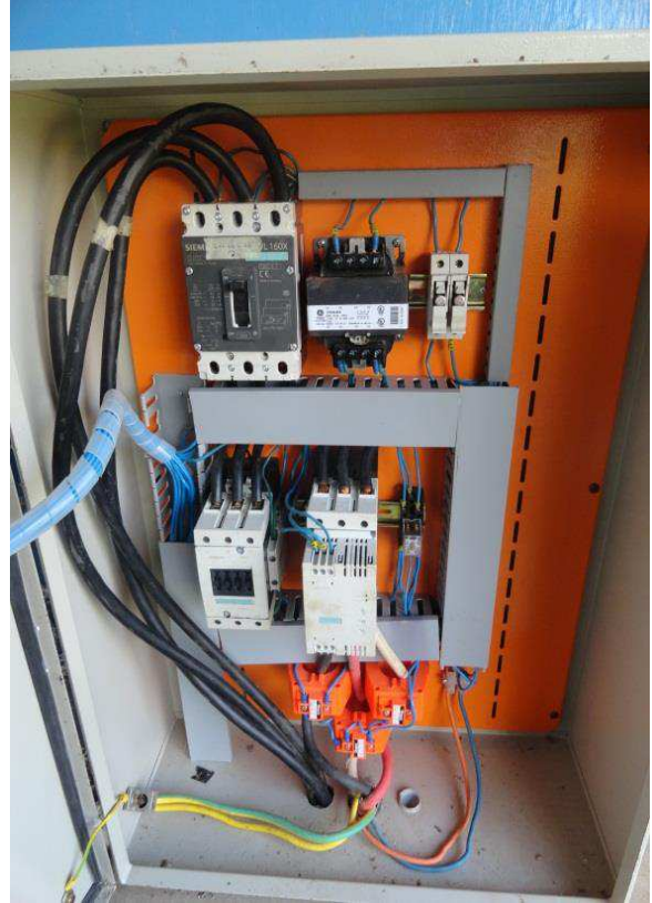
Figura N° 3.14: Tablero de control bomba agua cruda N° 3-60 HP
