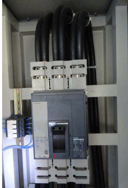
Figura N° 3.8: Tablero de control transformador T04e
