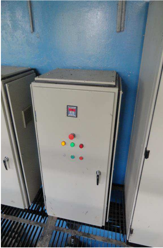
Figura N° 3.16: Tablero de control bomba agua cruda N° 5-87 HP
