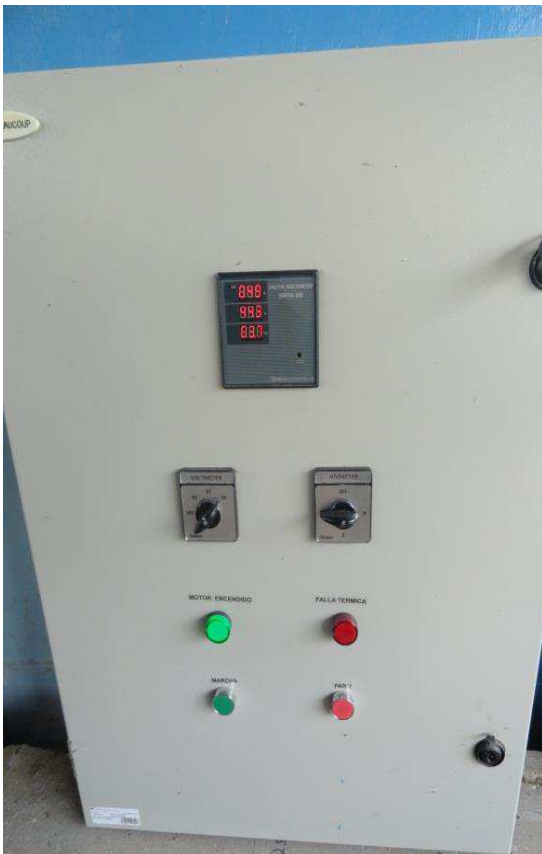
Figura N° 3.15: Tablero de control bomba agua cruda N° 4-60 HP
