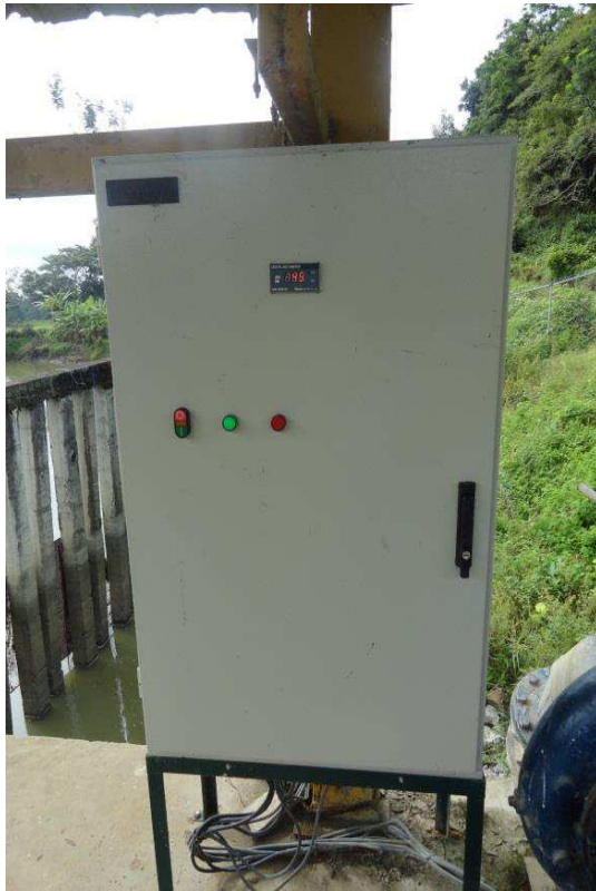
Figura N° 3.12: Tablero de control bomba agua cruda N° 1-150 HP
