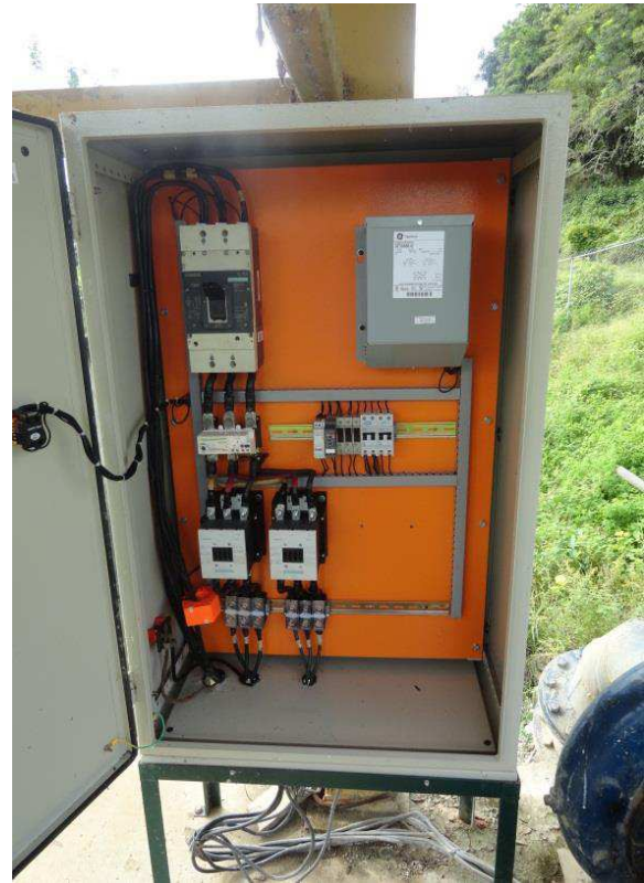
Figura N° 3.12: Tablero de control bomba agua cruda N° 1-150 HP
