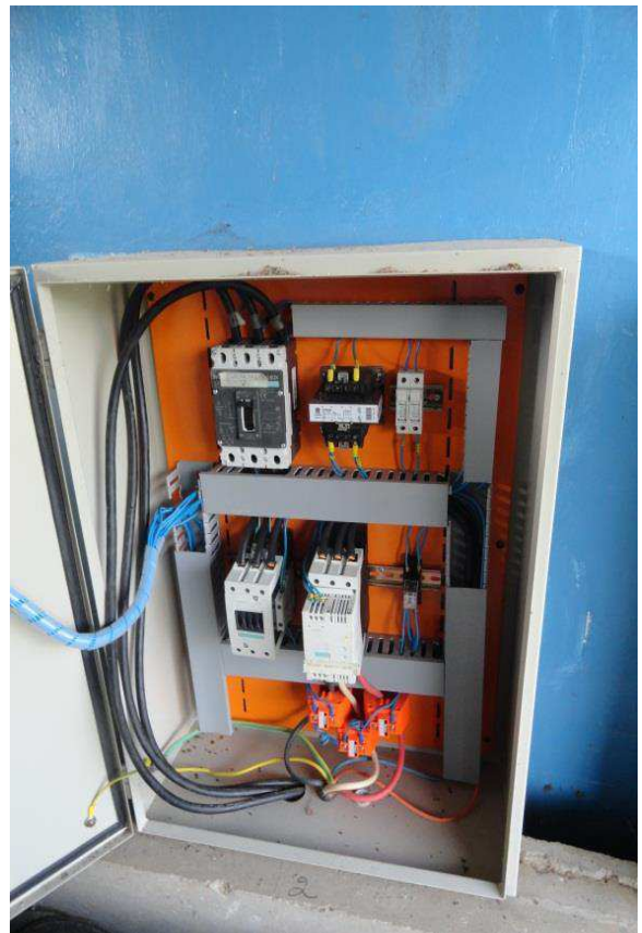
Figura N° 3.15: Tablero de control bomba agua cruda N° 4-60 HP
