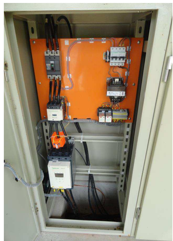
Figura N° 3.19: Tablero de control bombas presedimentadores nos. 1 y 2 - 50 HP
