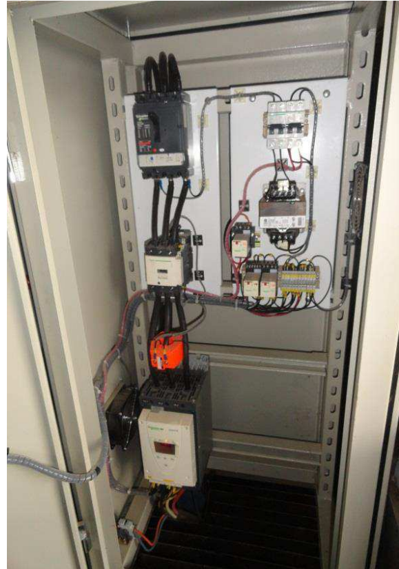
Figura N° 3.17: Tablero de control bomba agua cruda N° 6-87 HP
