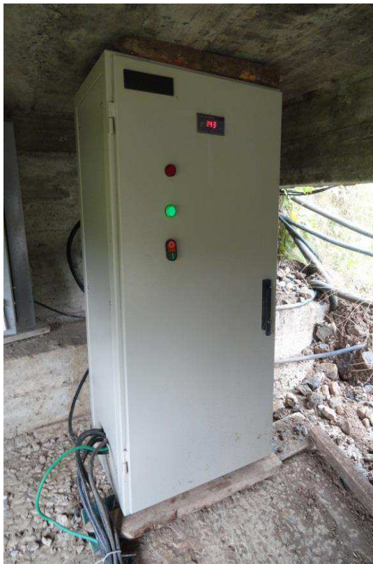
Figura N° 3.13: Tablero de control bomba agua cruda N° 2-150 HP
