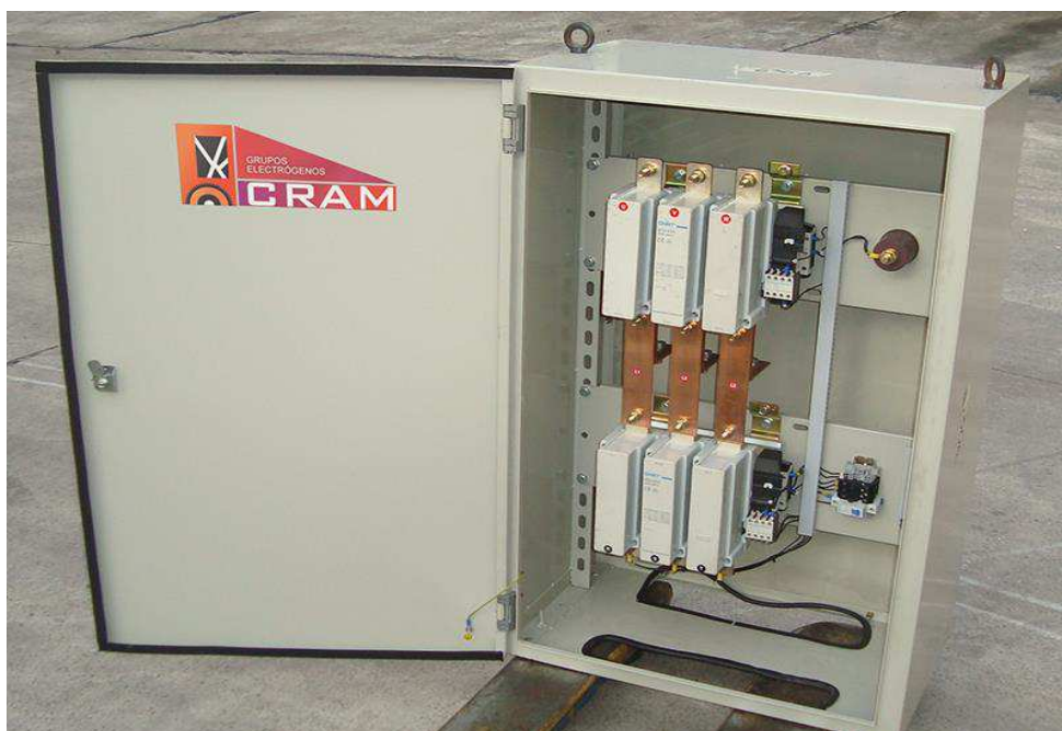
Figura 1.2: Tablero en construcción
