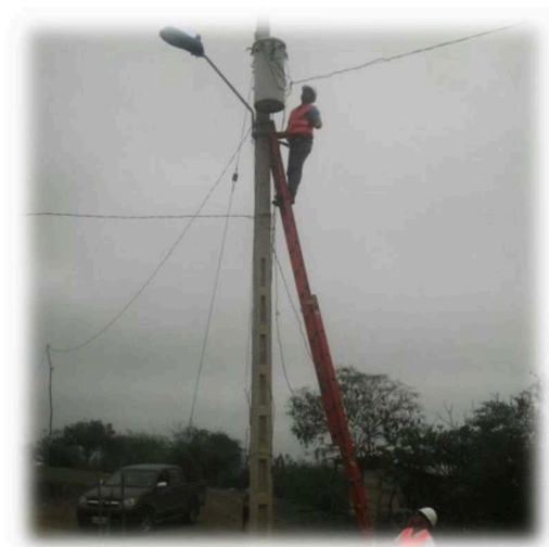
Tomando lectura en los bornes del transformador
