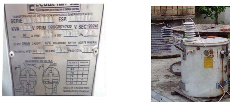
Figura1. 3 Transformador convencional de poste
