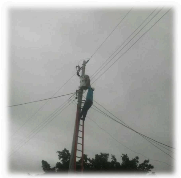
Tomando lectura en los bornes del transformador
