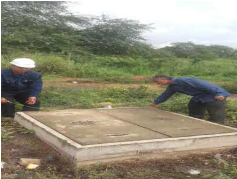
Pozo de revisión
