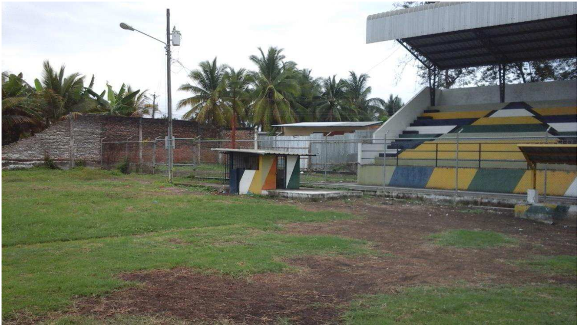
Gradas y poste de media y bajo red
