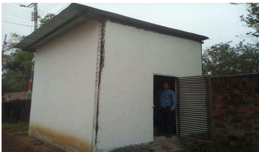
Figura de la caseta en la que se ubica el generador
