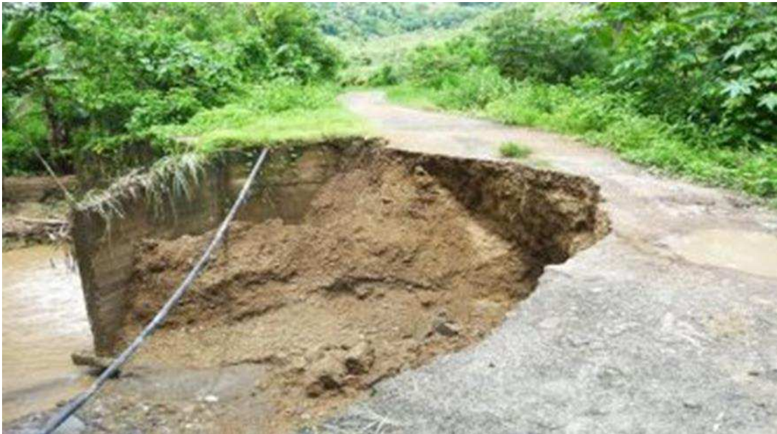
Anexo 4. Socavación del flujo del río en épocas de crecidas agua abajo del cantó Ana.
