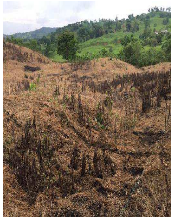
Fotografía 2. Limpieza del terreno
