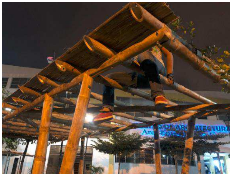
Figure 69.- Colocacion de Caña Picada - Grupo Investigador
