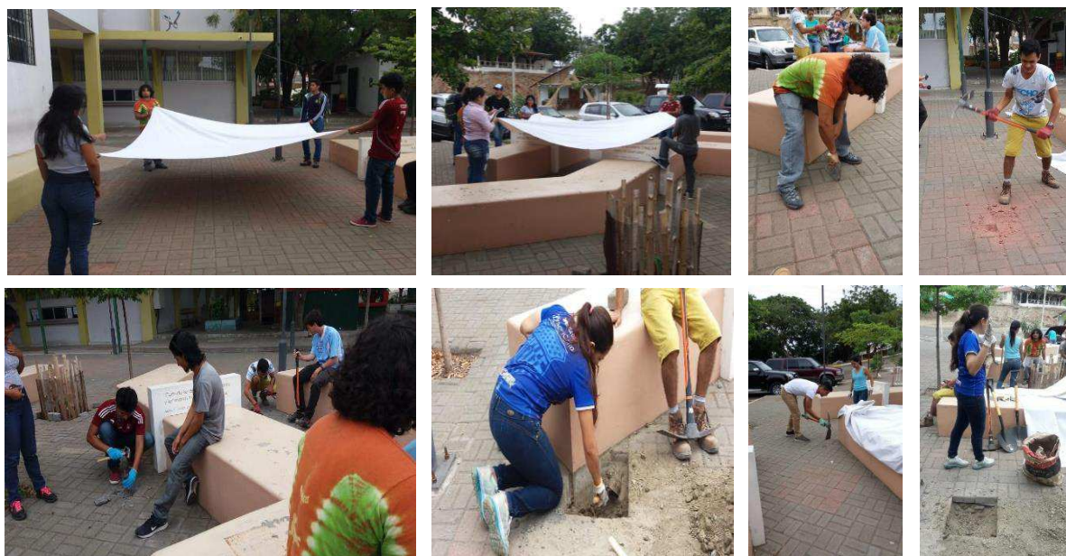
Figure 45.- Replanteo y Excavacion - Grupo Investigador
