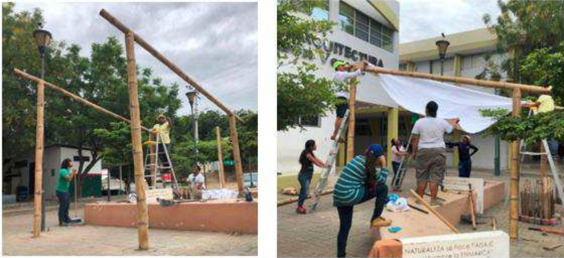
Figure 61.- Montaje de vigas y colocacion de lona - Grupo Investigador
