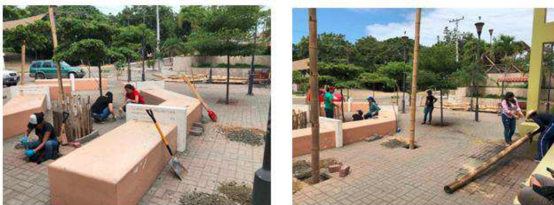
Figure 58.- Retiro de Adoquines y Realizacion de hoyos para empotar las cañas - Grupo Investigador
