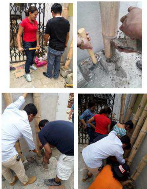
Figure 54.- Colocacion de Mortero en las Cañas - Grupo Investigador
