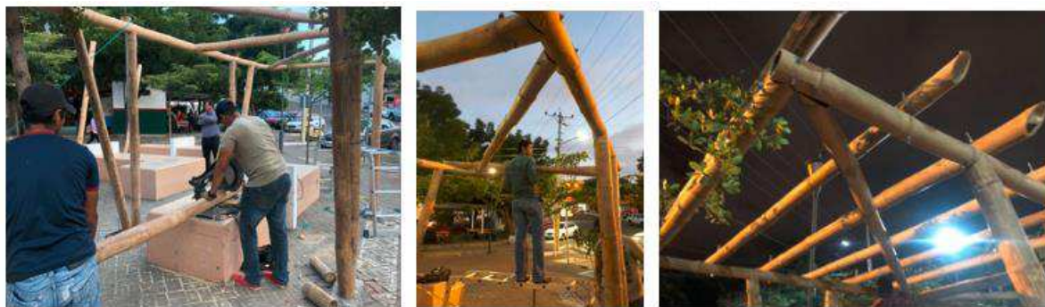
Figure 68.- Armado de Estructura - Grupo Investigador
