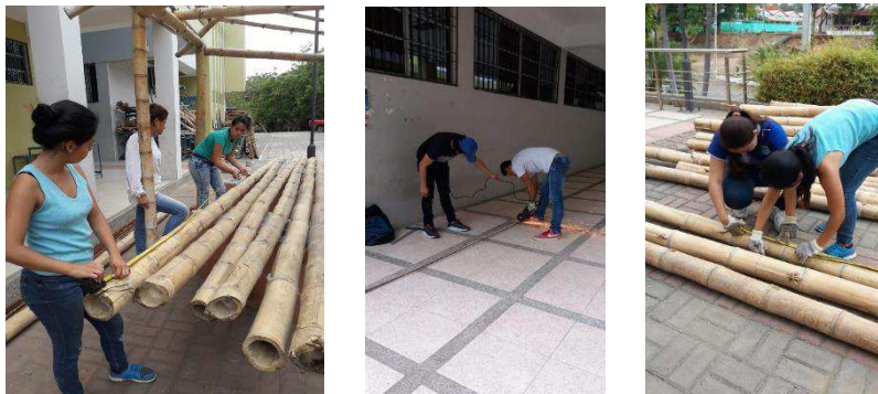
Figure 46.- Medidas y Cortes de Cañas - Grupo Investigador
