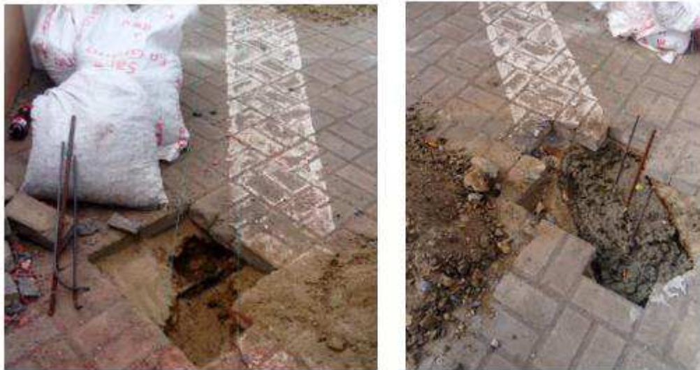
Figure 66.- Encofrado para colocacion de cañas - Grupo Investigador
