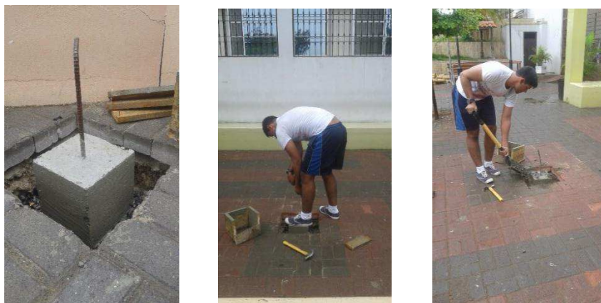
Figure 49.- Proceso de Encofrado - Grupo Investigador
