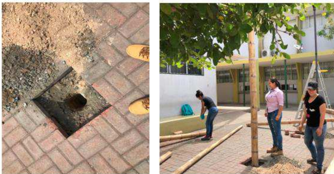
Figure 59.- Hoyo realizado para ubicar la caña como soporte - Grupo Investigador
