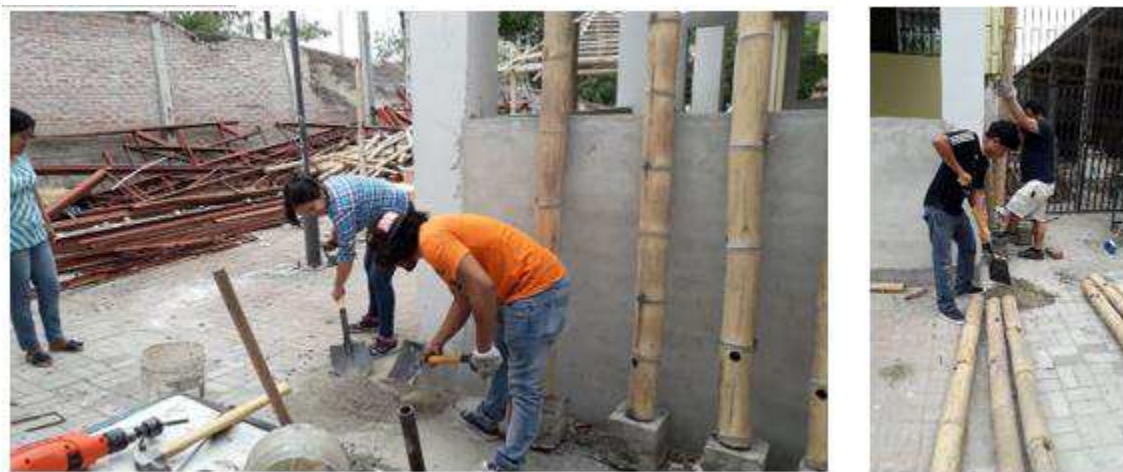
Figure 53.- Realizacion de Mortero - Grupo de Investigacion
