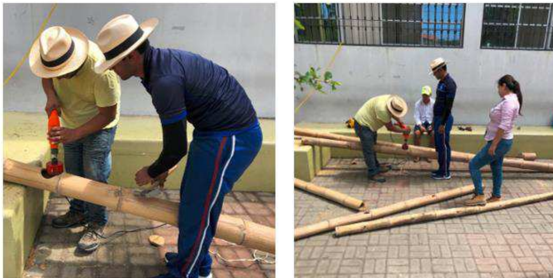
Figure 60.- Corte de cañas para ensamblado - Grupo Investigador
