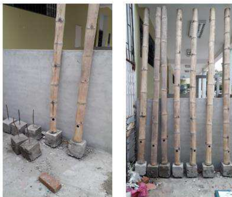
Figure 52.- Cañas listas para ser rellenas con mortero - Grupo Investigador
