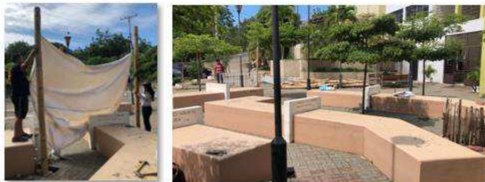
Figure 55.- Armado de Estructura - Grupo Investigador
