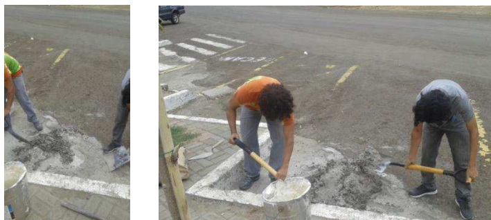
Figure 47.- Realizacion de Mortero - Grupo Investigador
