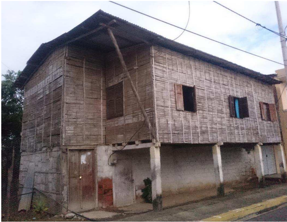
Imagen 26: vista frontal de la vivienda Fuente: trabajo de campo, fotografía, tesista.
