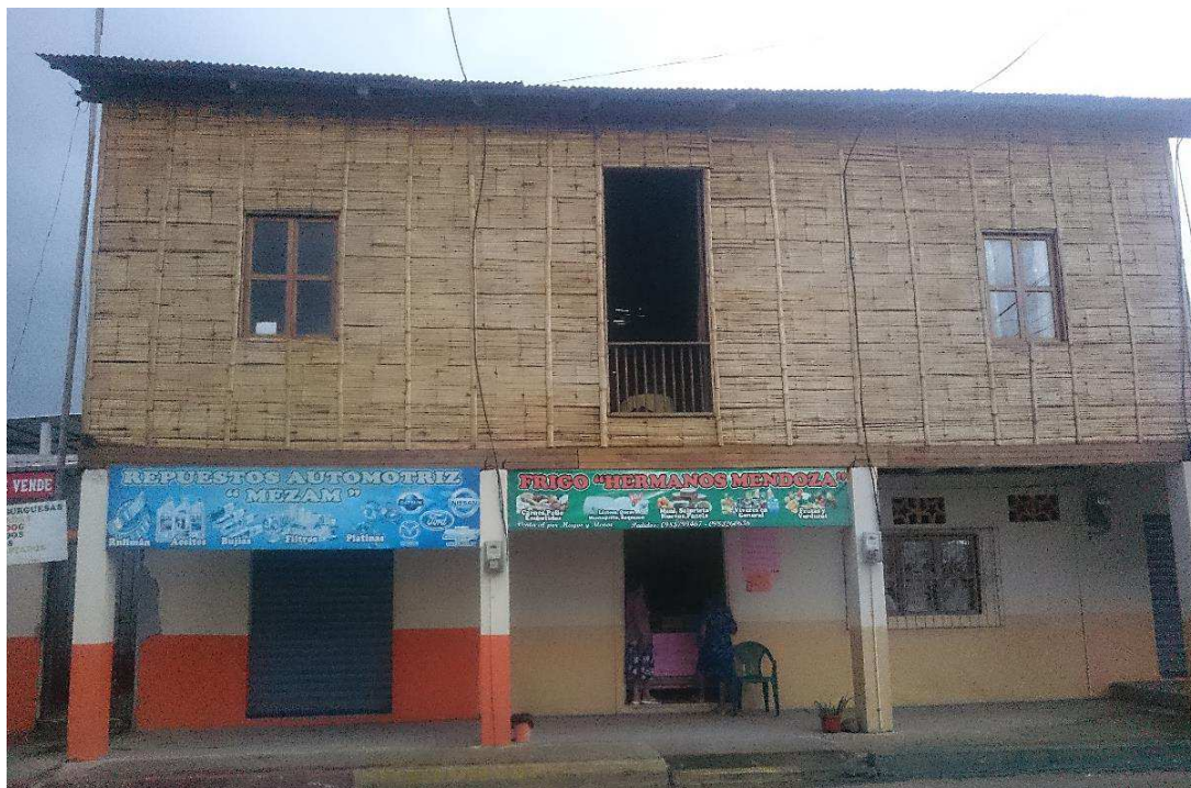
Imagen 29: fachada frontal de la vivienda Fuente: trabajo de campo, fotografía, tesista.
