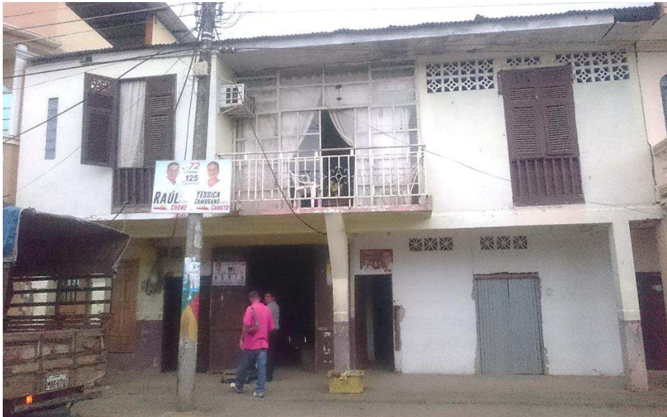
Imagen 28: vista frontal del inmueble Fuente: trabajo de campo, fotografía, tesista.
