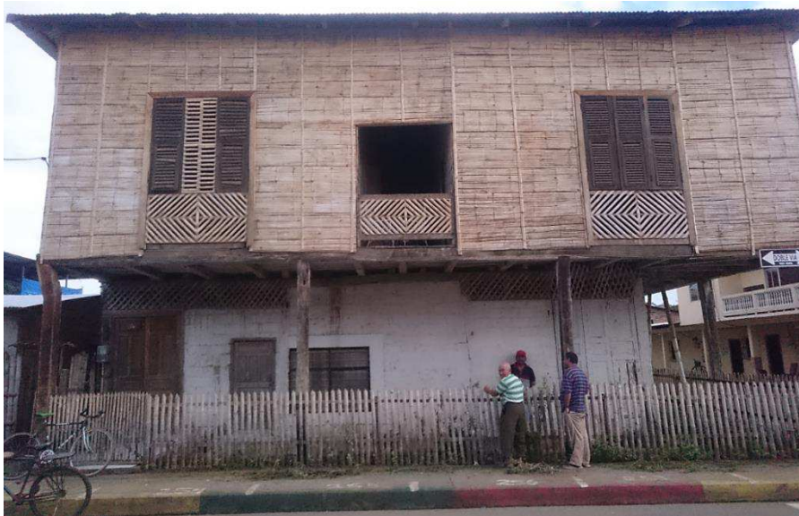
Imagen 25: fachada principal de la vivienda Fuente: trabajo de campo, fotografía, tesista.
