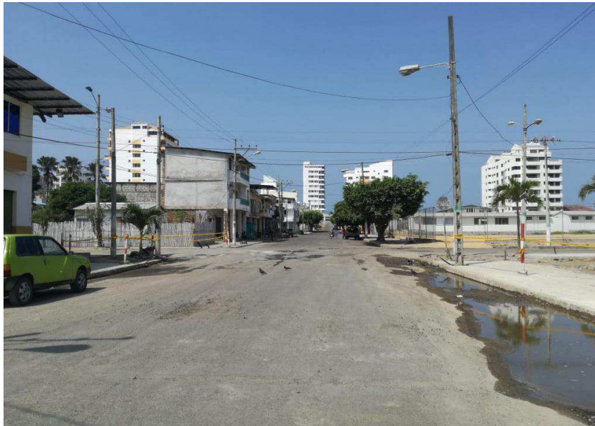
Anexo 5. Vista del área a intervenir. Decadencia de vías. Fuente: Investigador-Nathaly Intriago.
