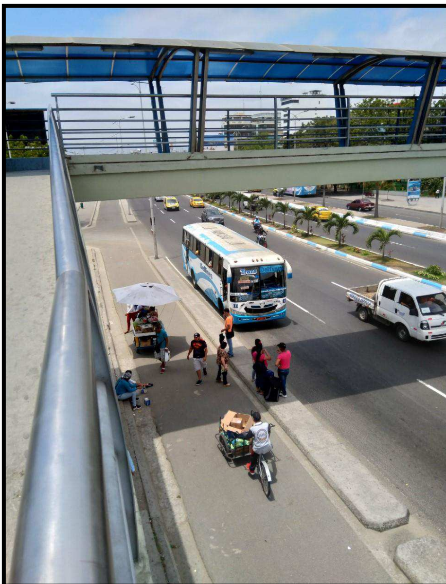
Ilustración 35: Evidencia de para de bus improvisada
