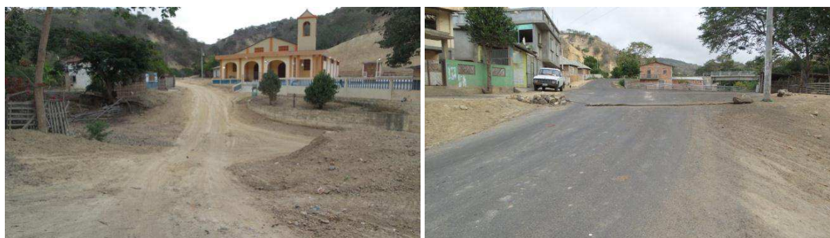
Imagen 62 y 63: Camino de verano (Vía lastrada firme). Vía asfaltada E15
