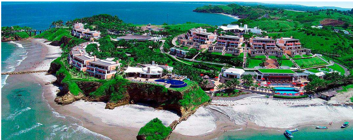
Imagen 20: Vista aérea de Hotel Resort Decameron Mompiche
