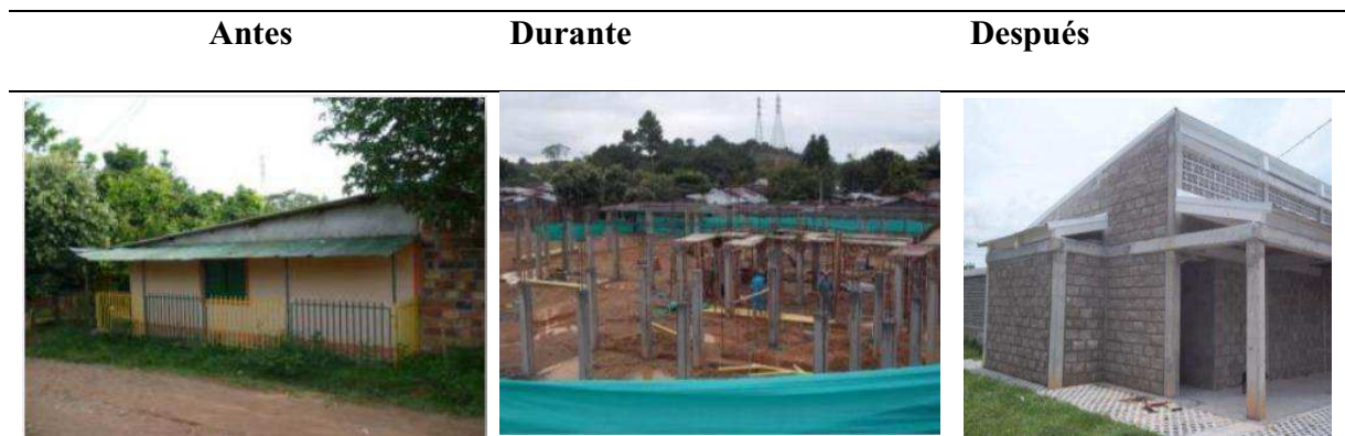
Imagen N°15: Intervención de centro de adulto mayor Fuente: Ministerio de Vivienda Colombia (2015)
