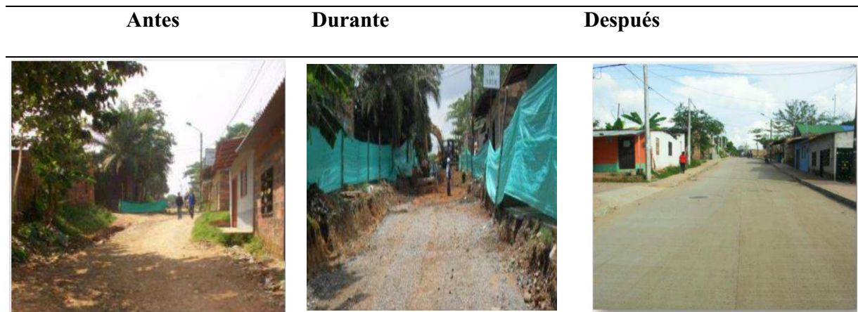
Imagen N°14: Intervenciones la calle 79 Fuente: Ministerio de Vivienda Colombia (2015)
